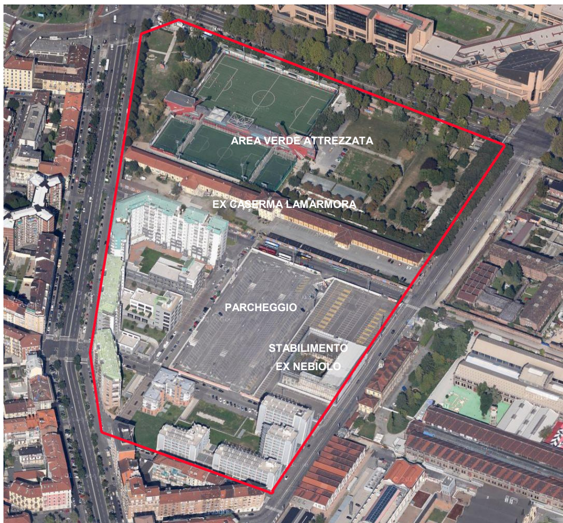
Figura 2: Vista aerea dell'area.
