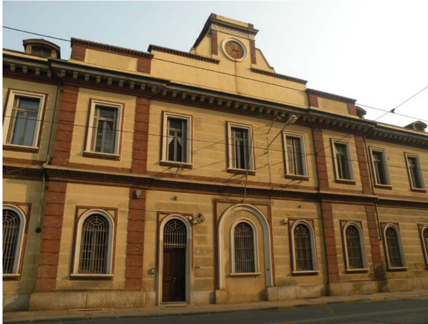
Figura 33 - Officine ferroviarie Via Boggio.
