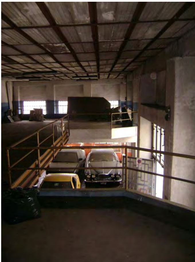
Vista dal piano soppalco
