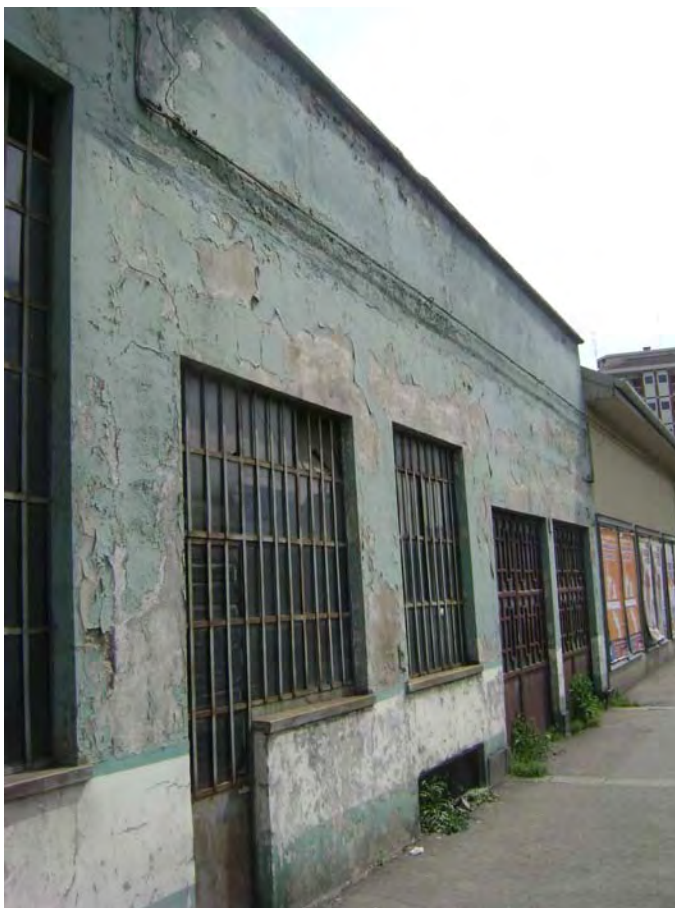
Particolare della facciata su via Cigna
