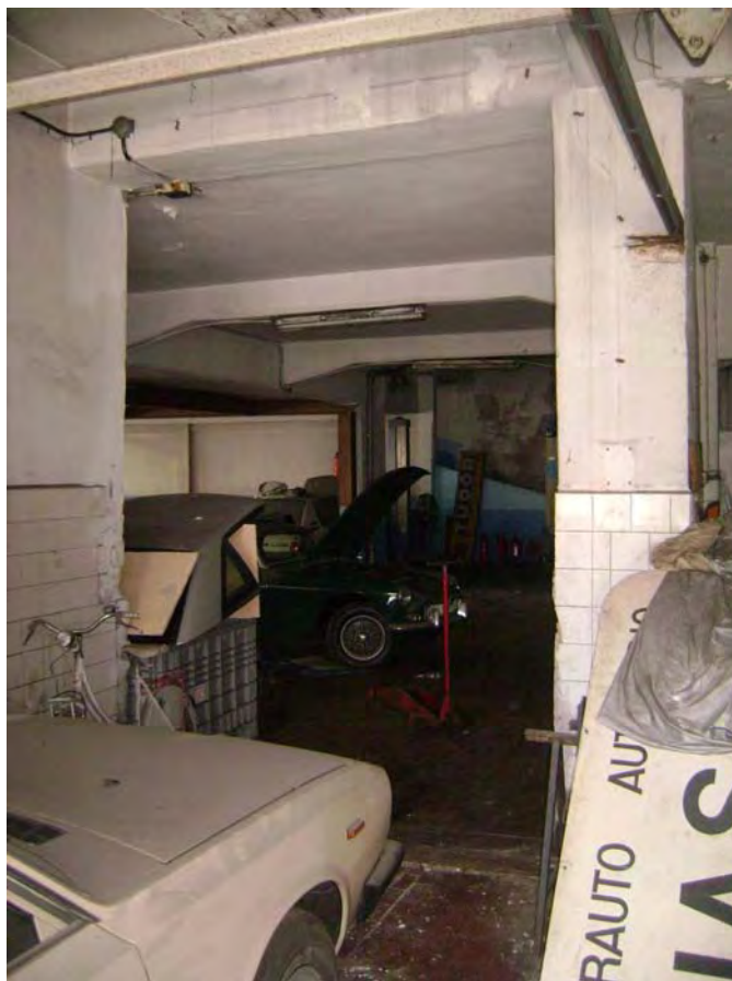
Vista dell'interno del fabbricato
