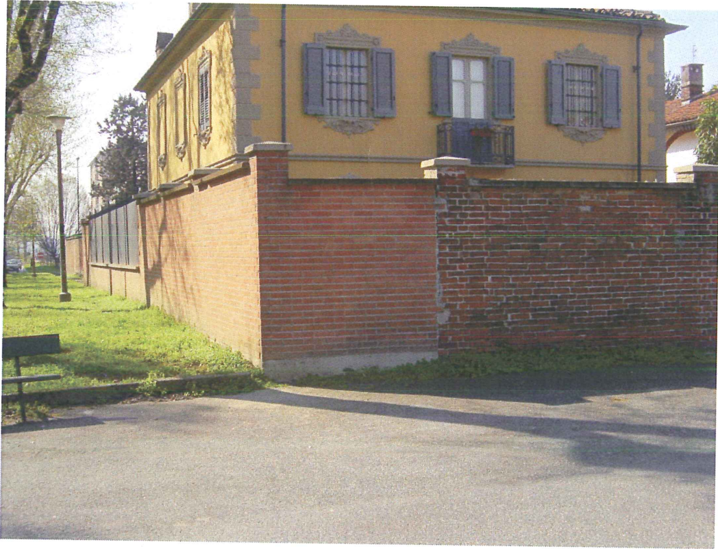
vista di via Morandi 6, angolo nord-est
