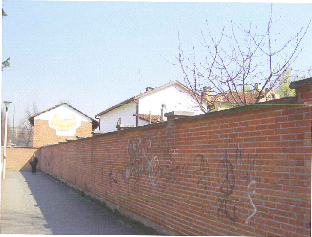
vista di via Morandi 6, lato ovest
