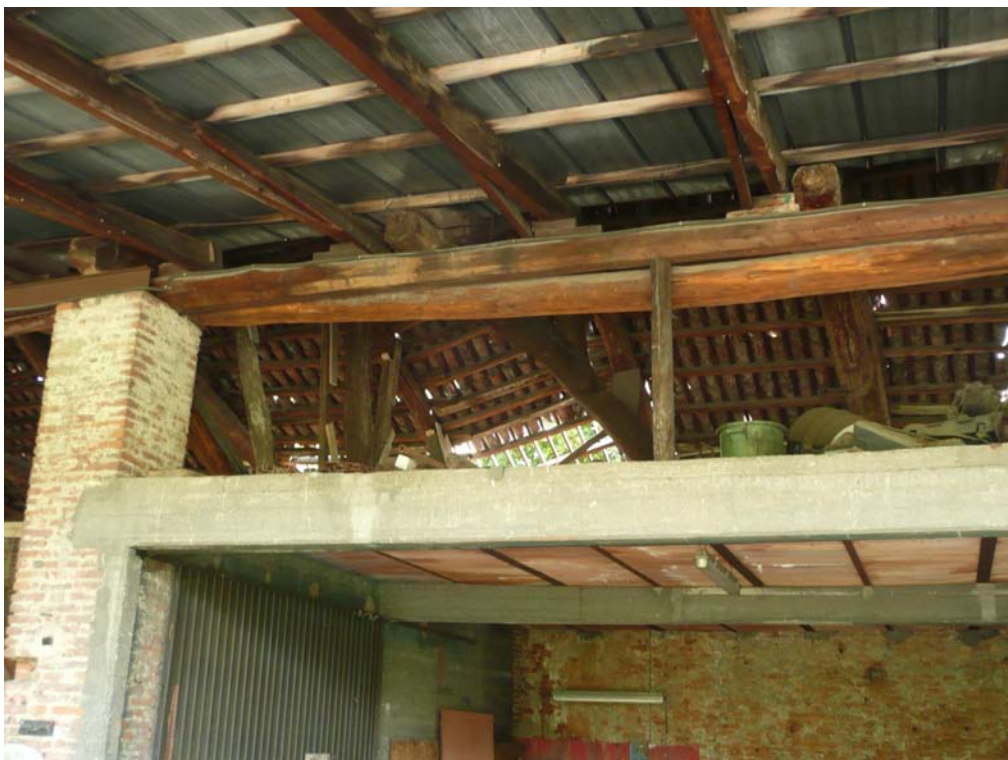
8. Particolare della copertura del fienile
