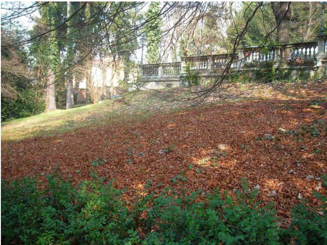
Terrapieno sotto area a parcheggio
