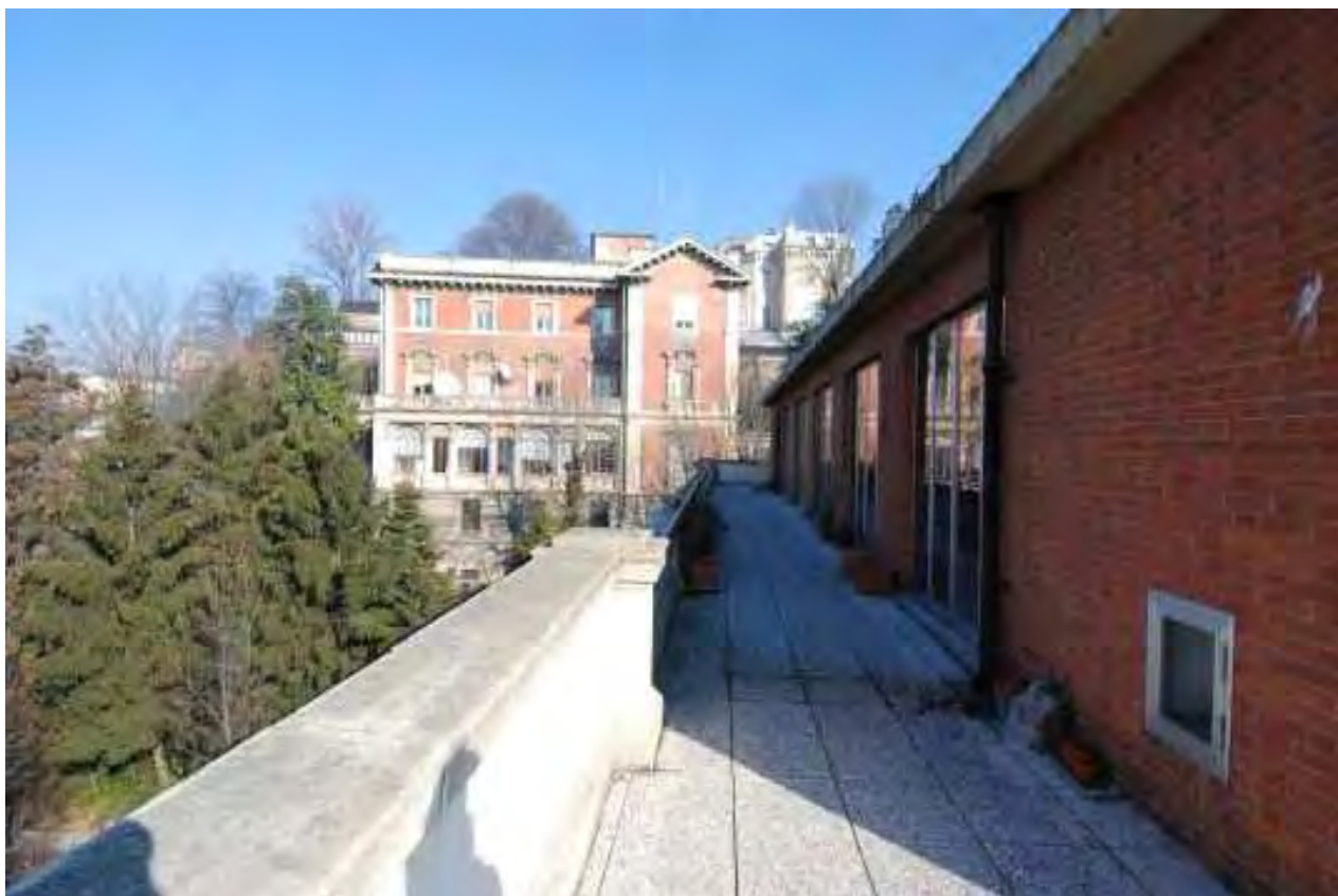
Vista terrazzo dal Padiglione B verso Padiglione C
