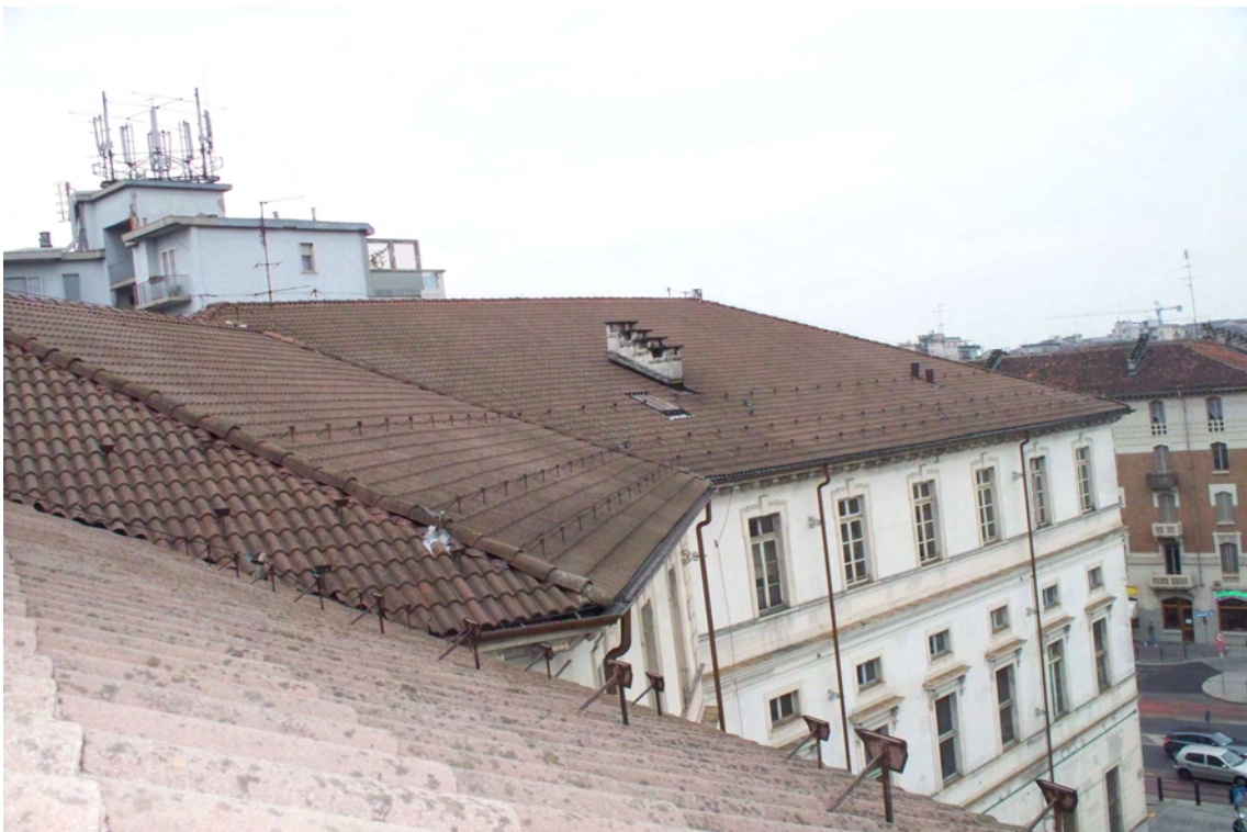
Vista della copertura esistente
