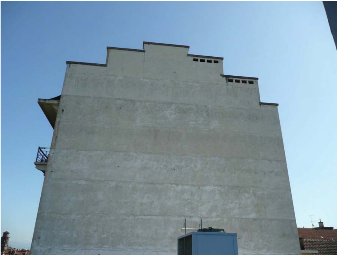
fronte cieco edificio altra proprietà dal tetto dell'edificio su Corso Siccardi
