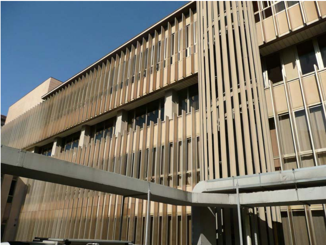
vista della facciata interna dell'edificio su Corso Siccardi
