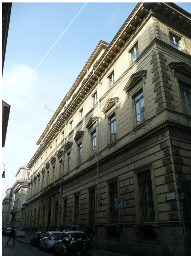
Vista imm.le lato via Corte d' Appello n. 10 (direzione via Sant' Agostino)
