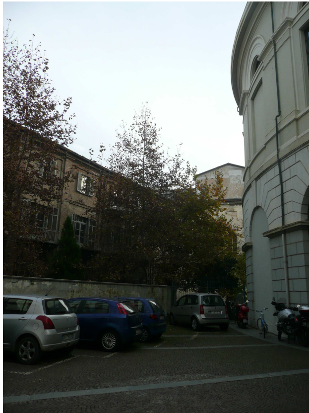
Vista imm.le interno cortile
