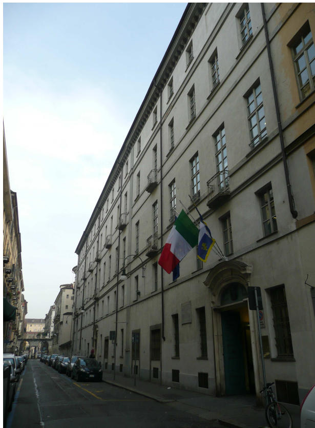
Vista imm.le lato via San Francesco da Paola n. 3 (direzione via Po)
