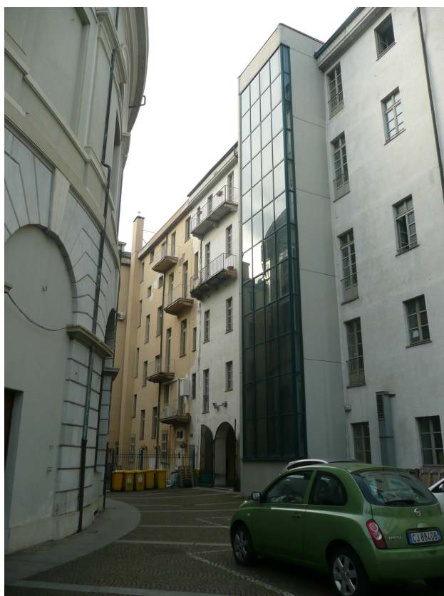
Vista imm.le interno cortile
