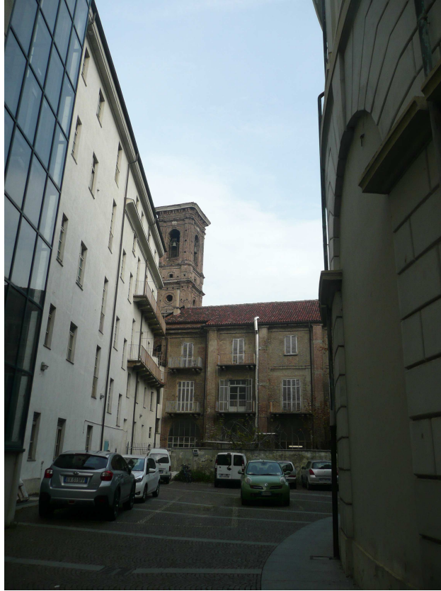
Vista imm.le interno cortile
