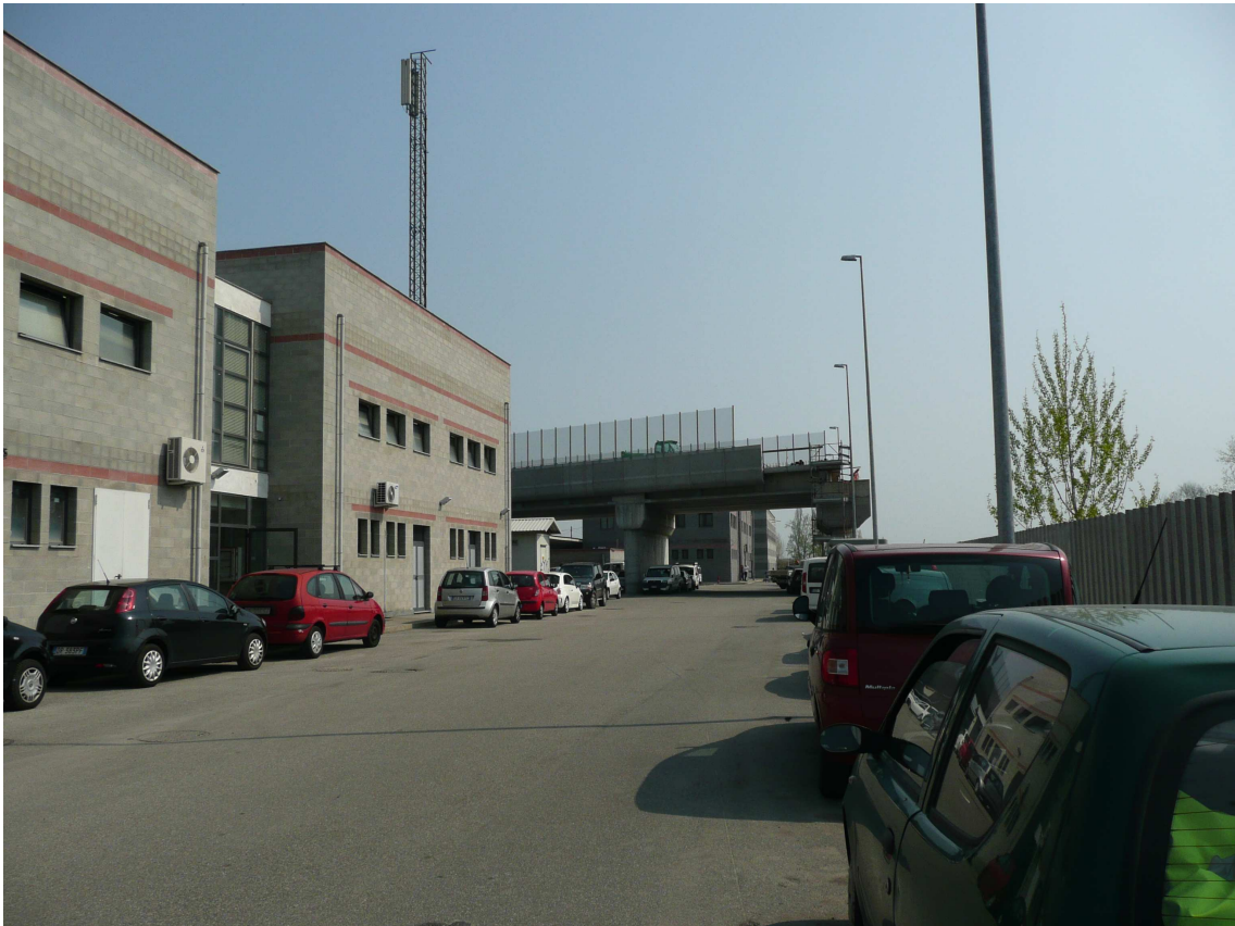
Vista sopraelevata a scavalco Stazione "Stura"
