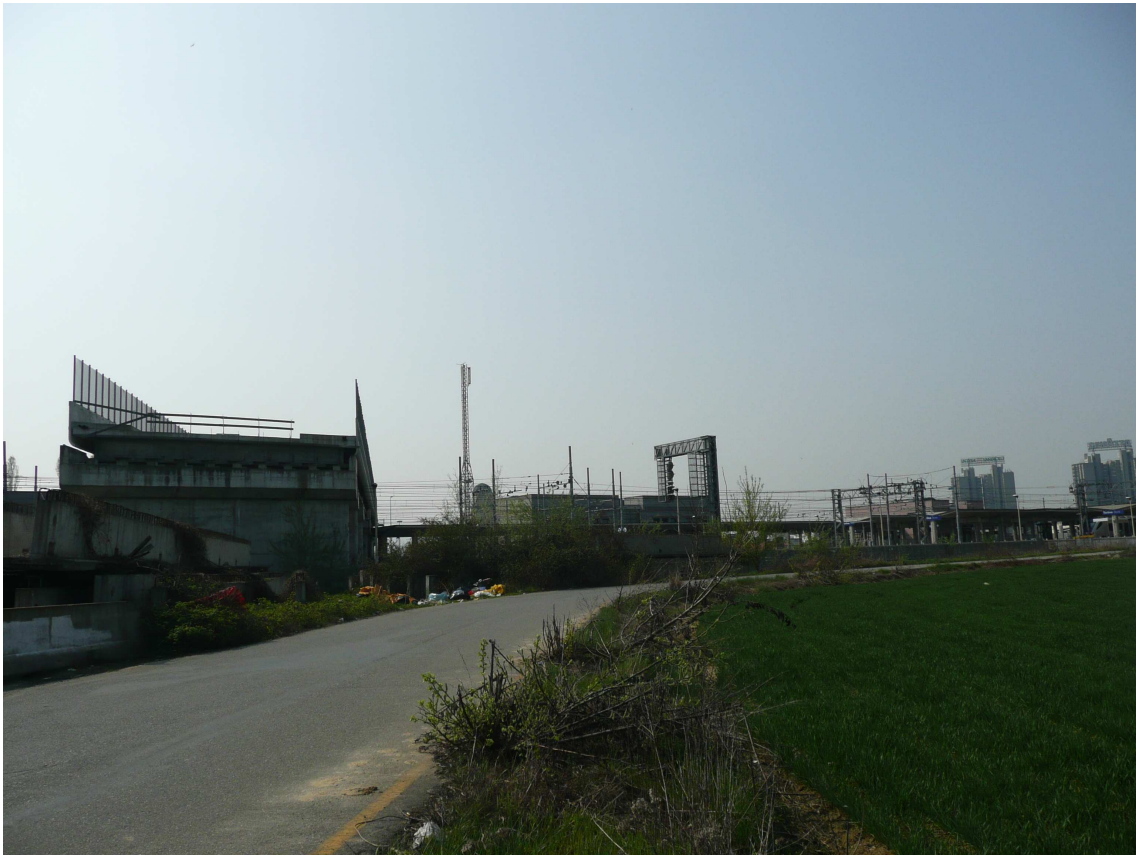
Vista sopraelevata a scavalco Stazione "Stura" in direzione corso Romania
