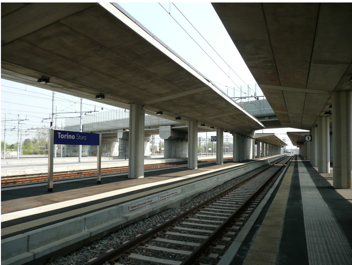
Vista sopraelevata a scavalco Stazione "Stura"
