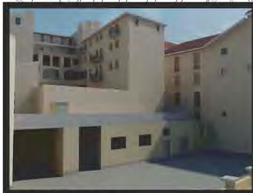
Vista dell'oratorio prima della demolizione
