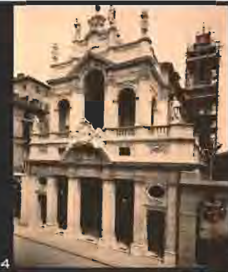
1934_G.GABINIO, Chiesa dell'Annunziata Nuova, Via Po 49, facciata, vista di scorcio da Sud-Est, durante la costruzione del campanile. (Archivio Gabrino - GAM)
