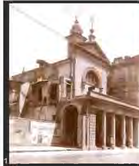
1925_G.GABINIO, Chiesa dell'Annunziata, Via Po 49. (ora civico n° 45) vista di scorcio da Ovest durante le prime demolizioni. (Archivio Gabrino - GAM)
