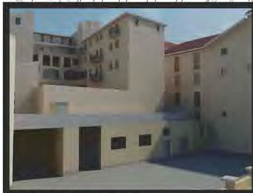
Vista dell'oratorio prima della demolizione
