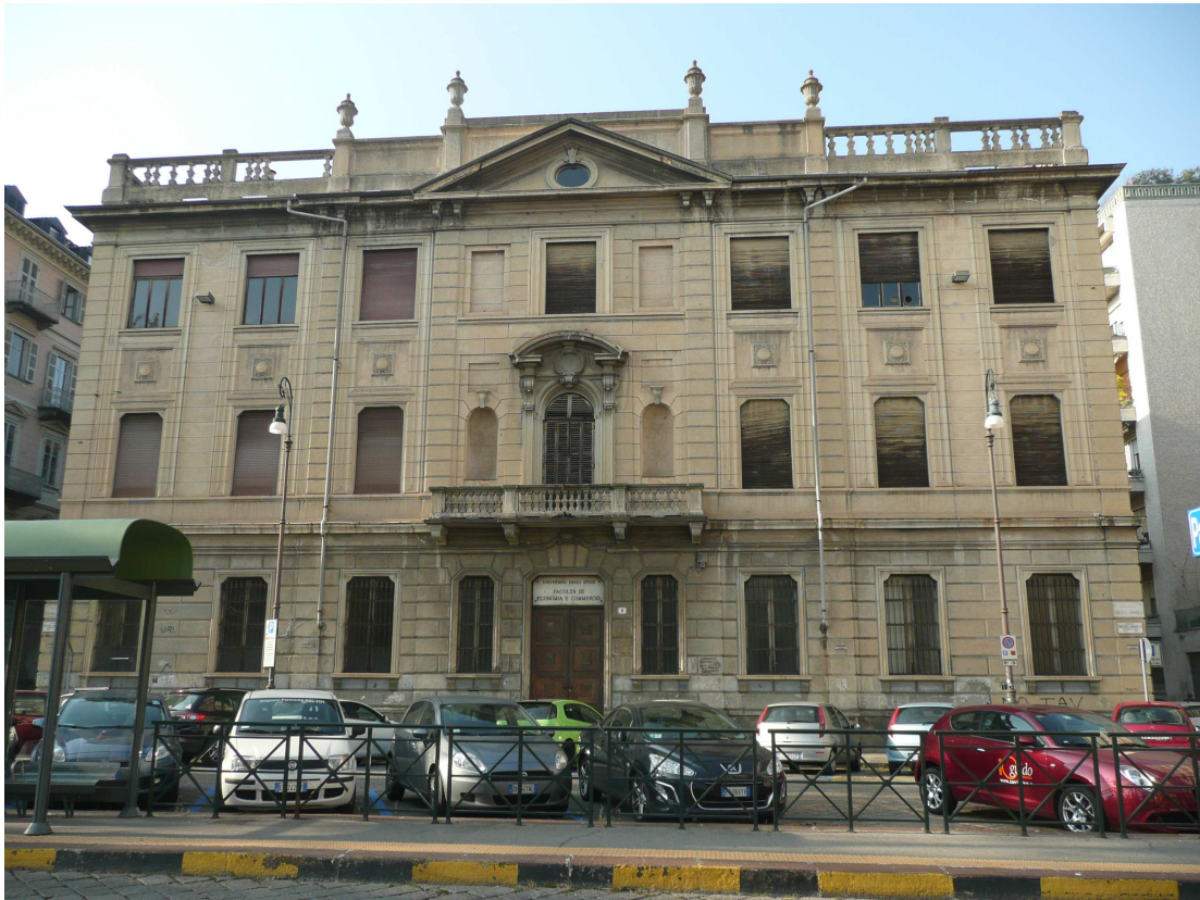
Vista frontale dell'edificio in piazza Arbarello 8 – lato piazza Arbarello
