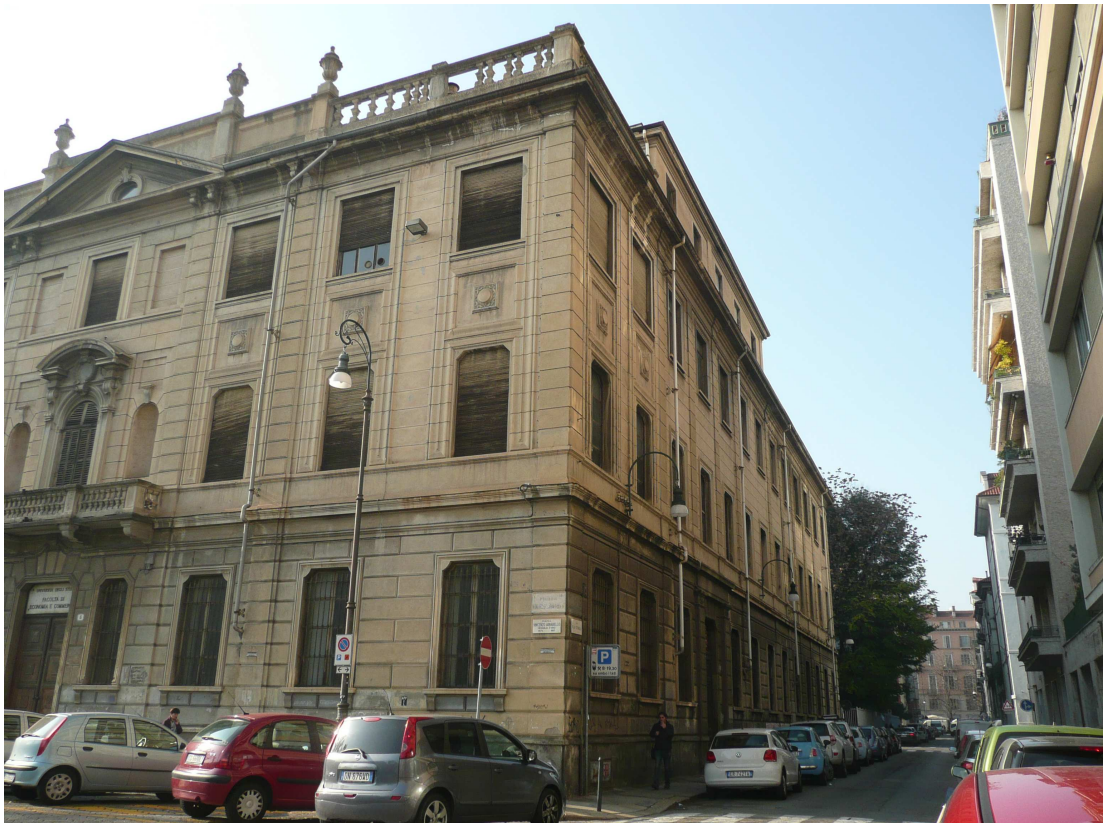
Vista laterale dell'edificio in piazza Arbarello 8 – lato via della Cittadella ang. piazza Arbarello
