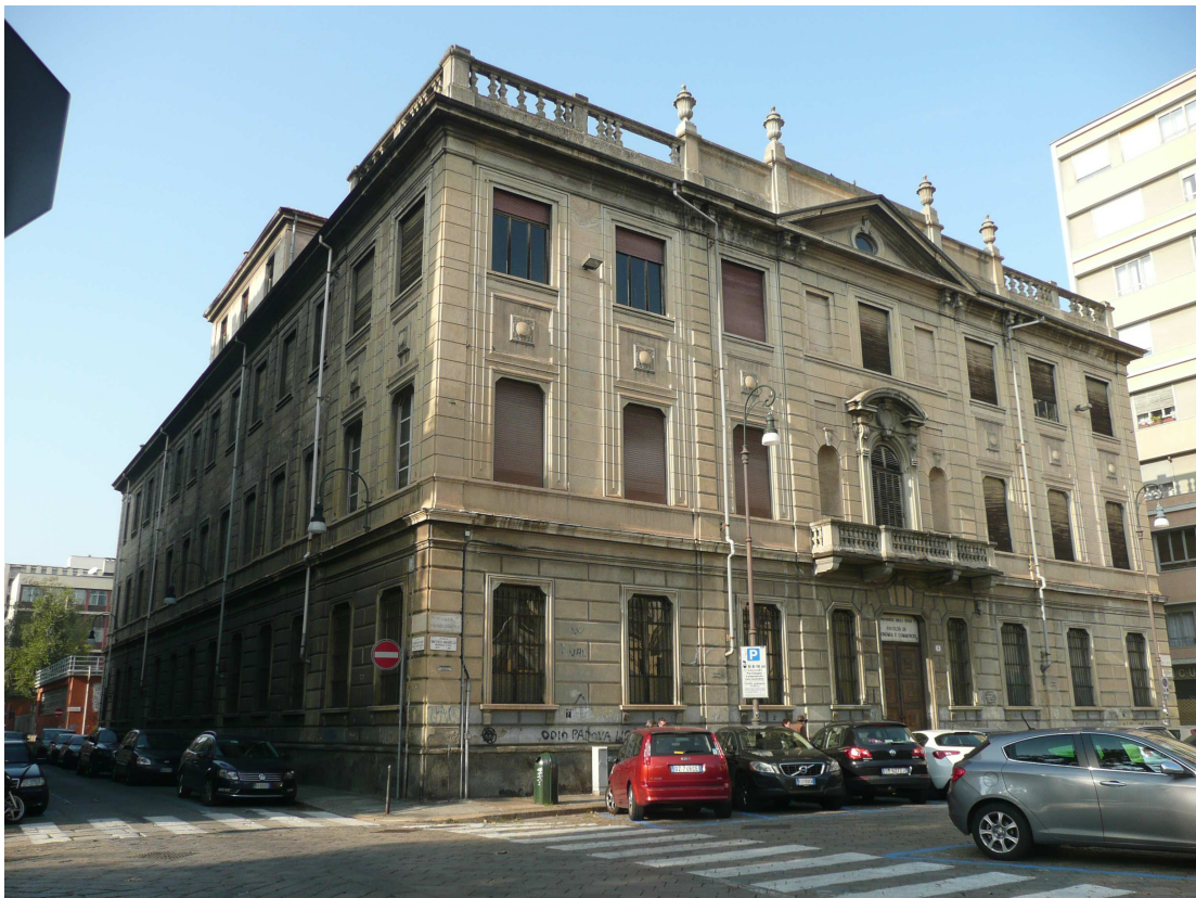
Vista laterale dell'edificio in piazza Arbarello 8 – lato via Bertrandi ang. piazza Arbarello
