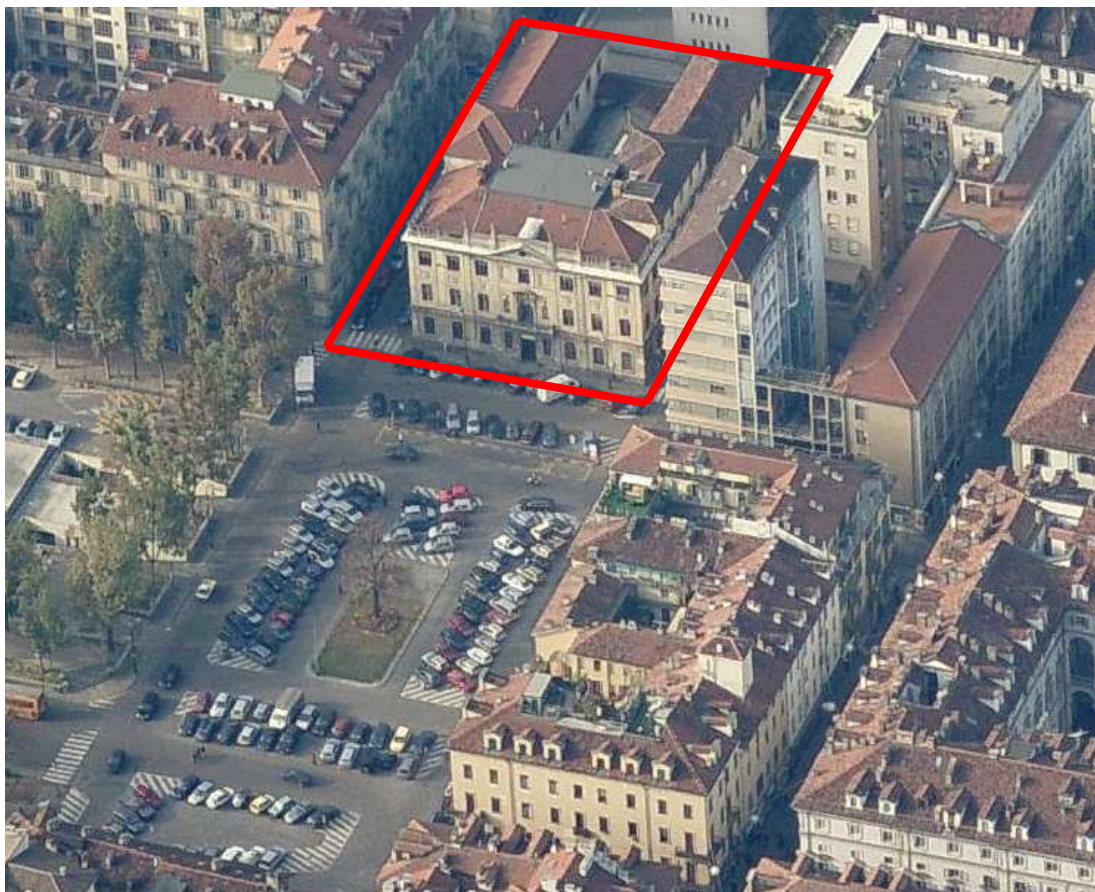
Vista aerea dell'edificio in piazza Arbarello 8 – lato piazza Arbarello
