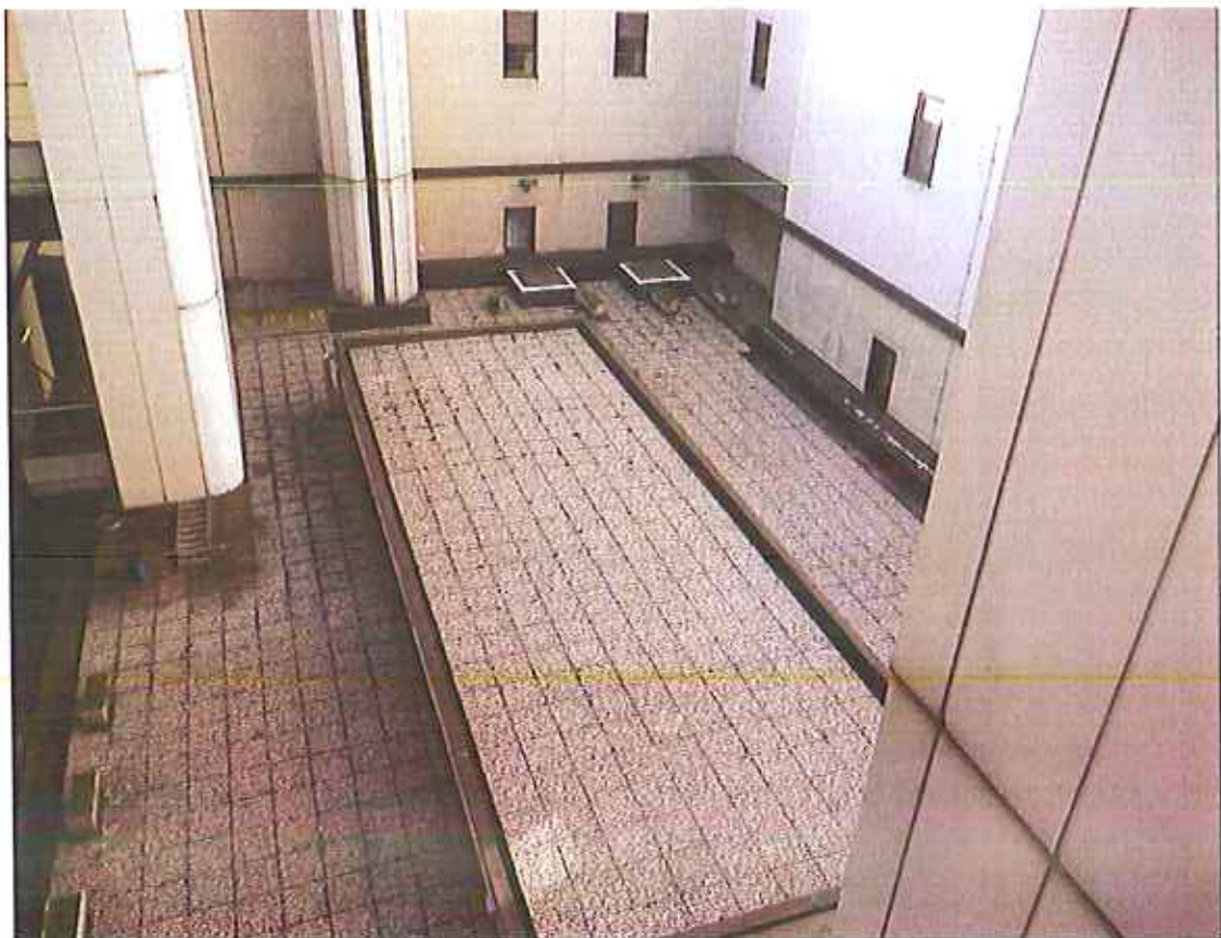
Vista della copertura delle sale congressi e della hall
