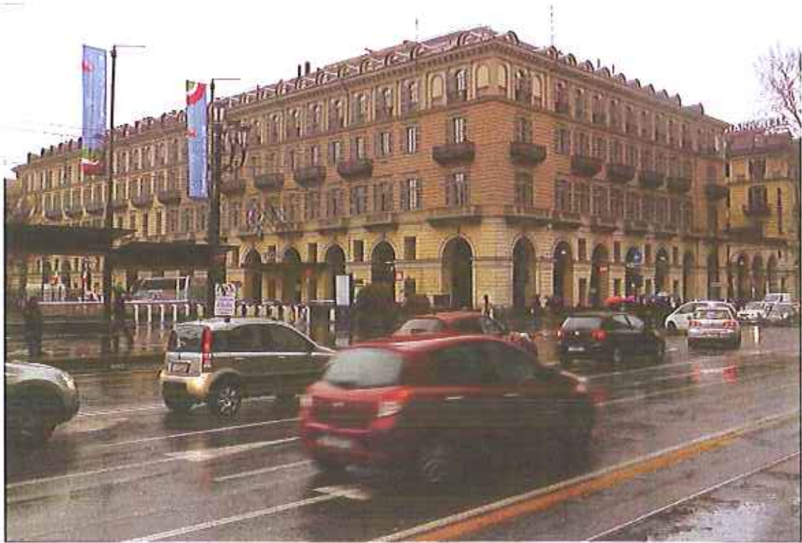
Vista del fabbricato dalla stazione di Porta Nuova
