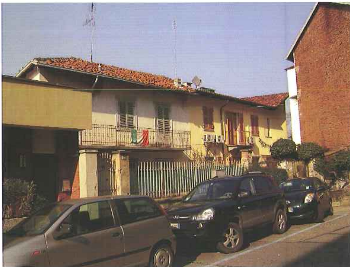
Vista fabbricato su via Luigi del Carretto
