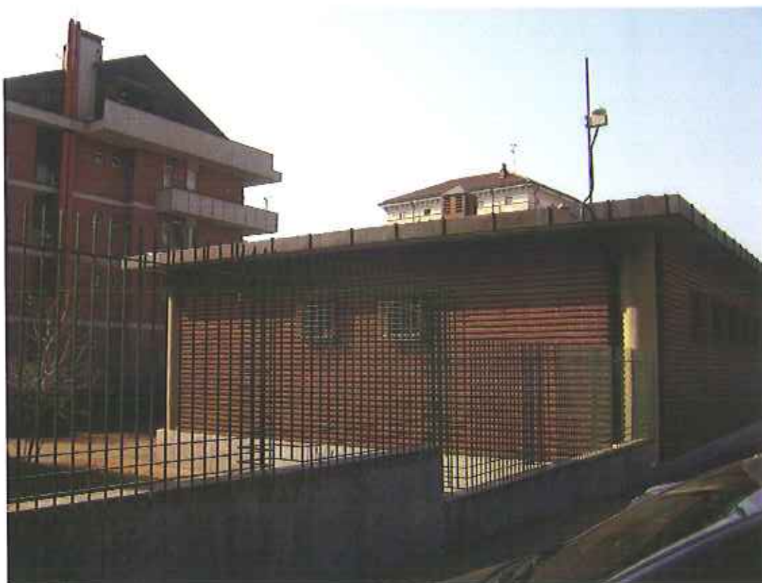
Vista laterale dell' ex fabbricato SIP
