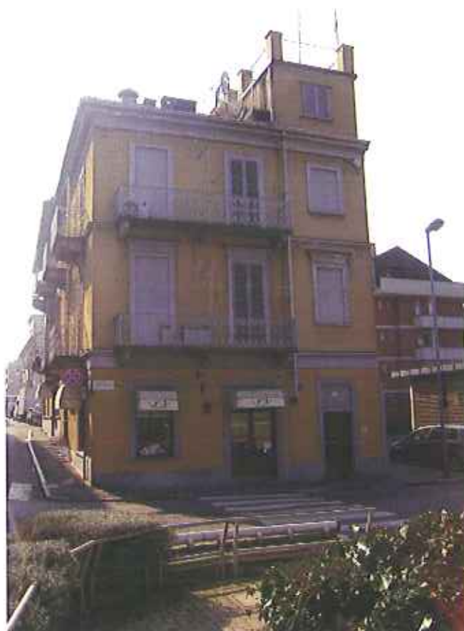
Particolare della facciata del fabbricato su piazza Hermada
