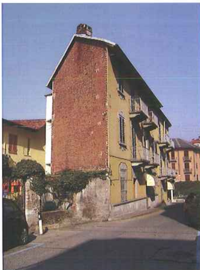
Vista fabbricato su via Luigi del Carretto
