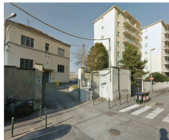
D - Accesso all'area da Via Brugnone
