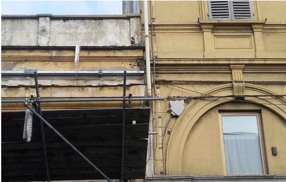
Foto 2 Dettaglio Cornicione con edificio attiguo.
