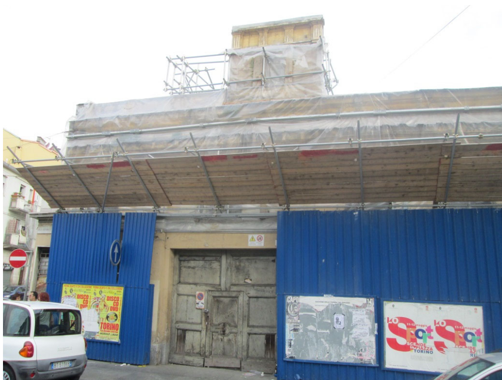
Figura 3 Ingresso cantiere Piazza delle Repubblica n.13
