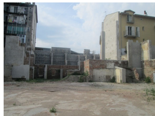
Vista interna _verso Piazza della Repubblica
