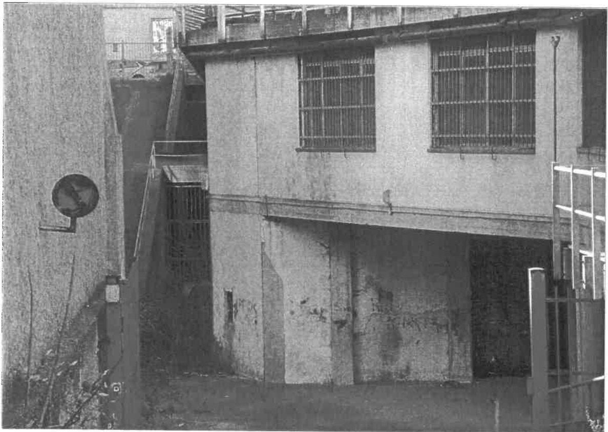
Foto n° 3: zona ingresso di servizio
