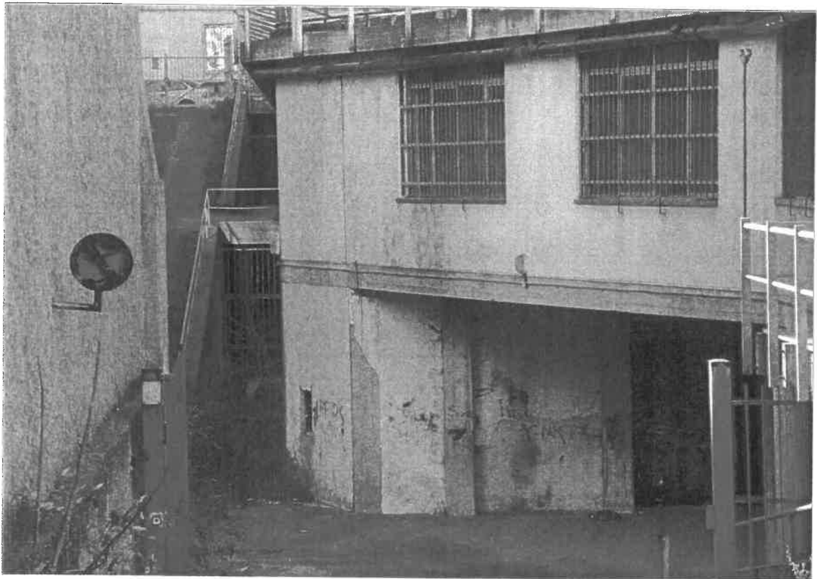
Foto n° 3: zona ingresso di servizio
