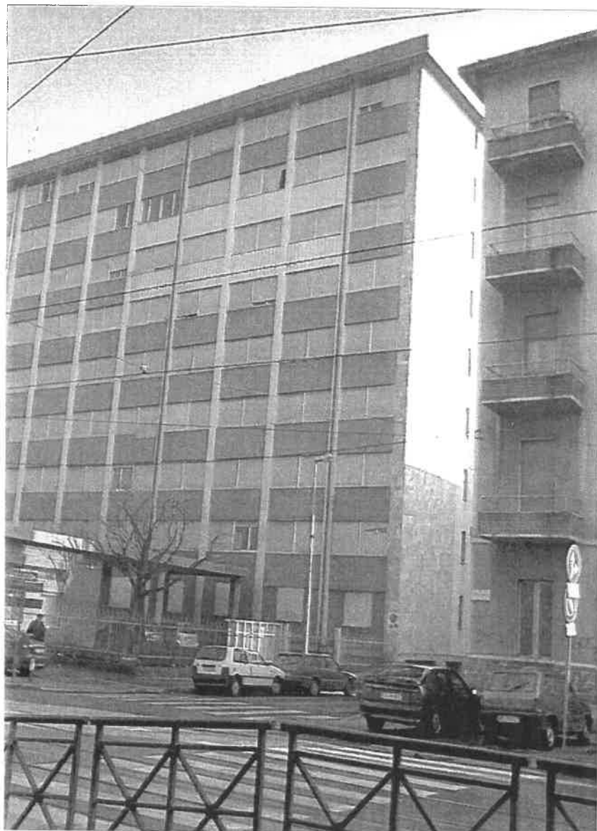
Foto n° 1: vista via Bologna angolo via Padova
