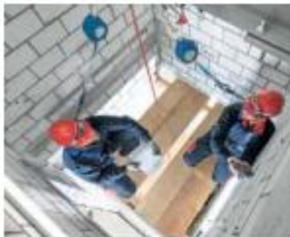
2 Ponteggio per il vano ascensore
