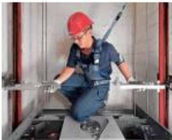
1 Tetto della cabina
