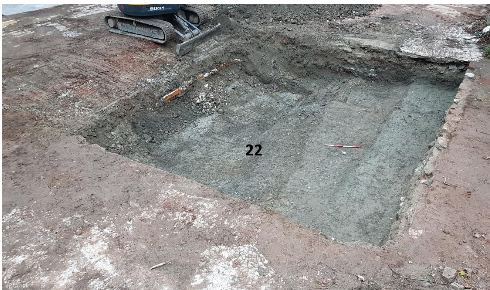
Andamento a gradoni di us 22
