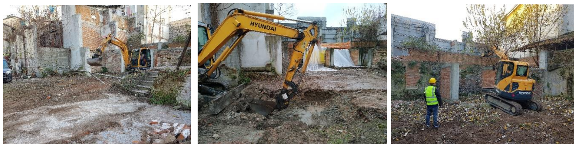
Il mezzo meccanico utilizzato, con benna liscia, dentata e martellone
