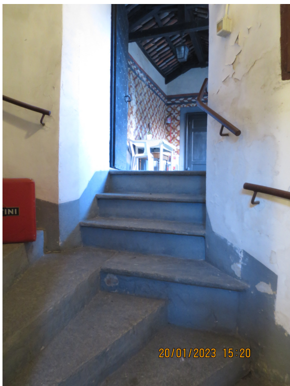
208 Accesso a loggiato da torretta
