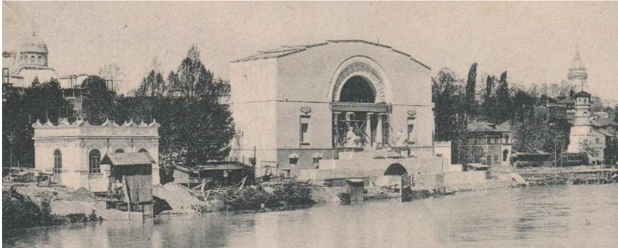
Il padiglione russo in costruzione
