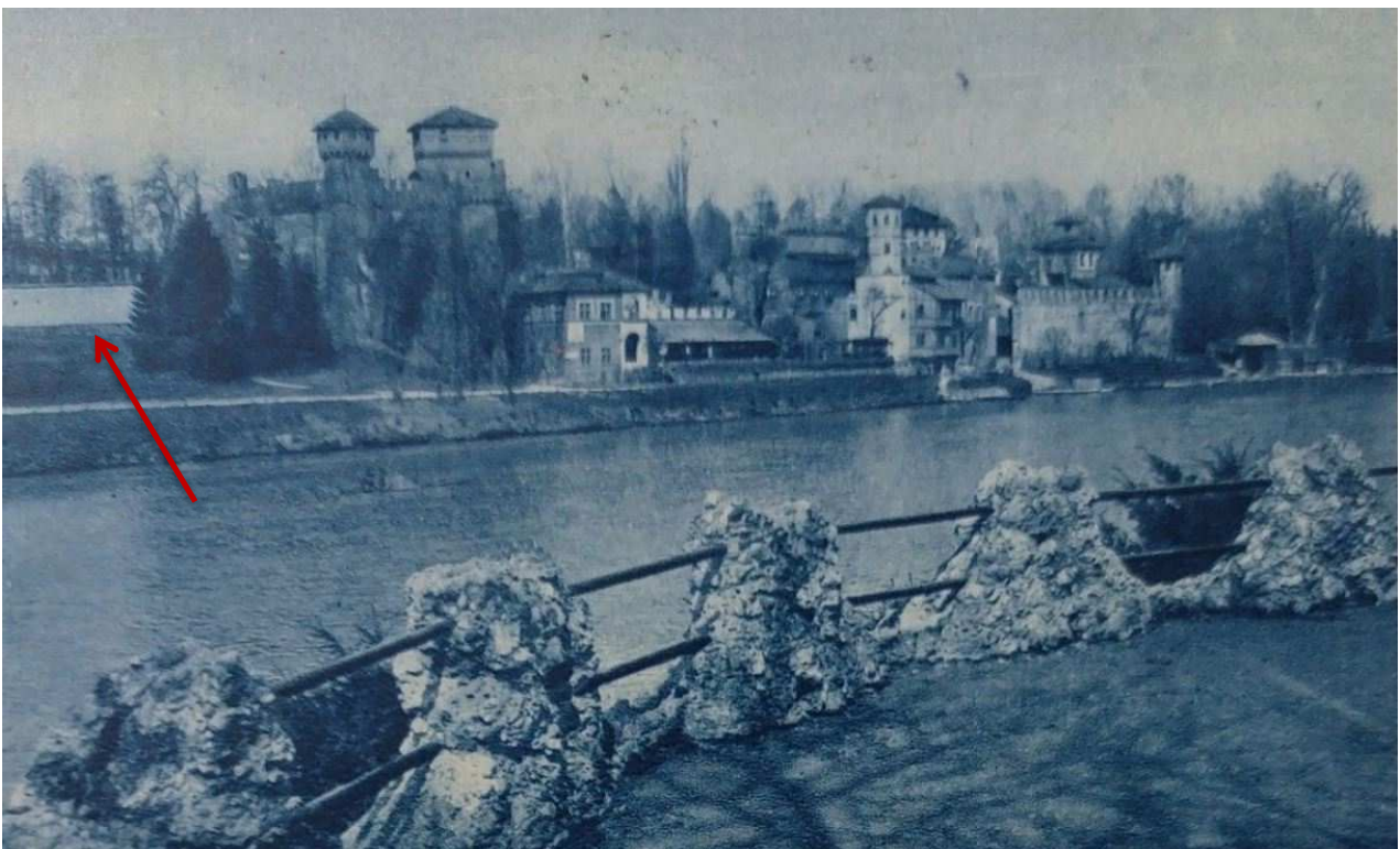
Il retro dell'edificio dell'aquarium visto dal fiume
