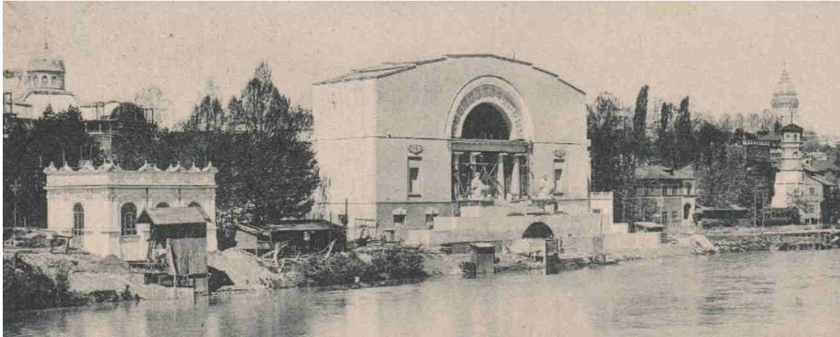
Il padiglione russo in costruzione
