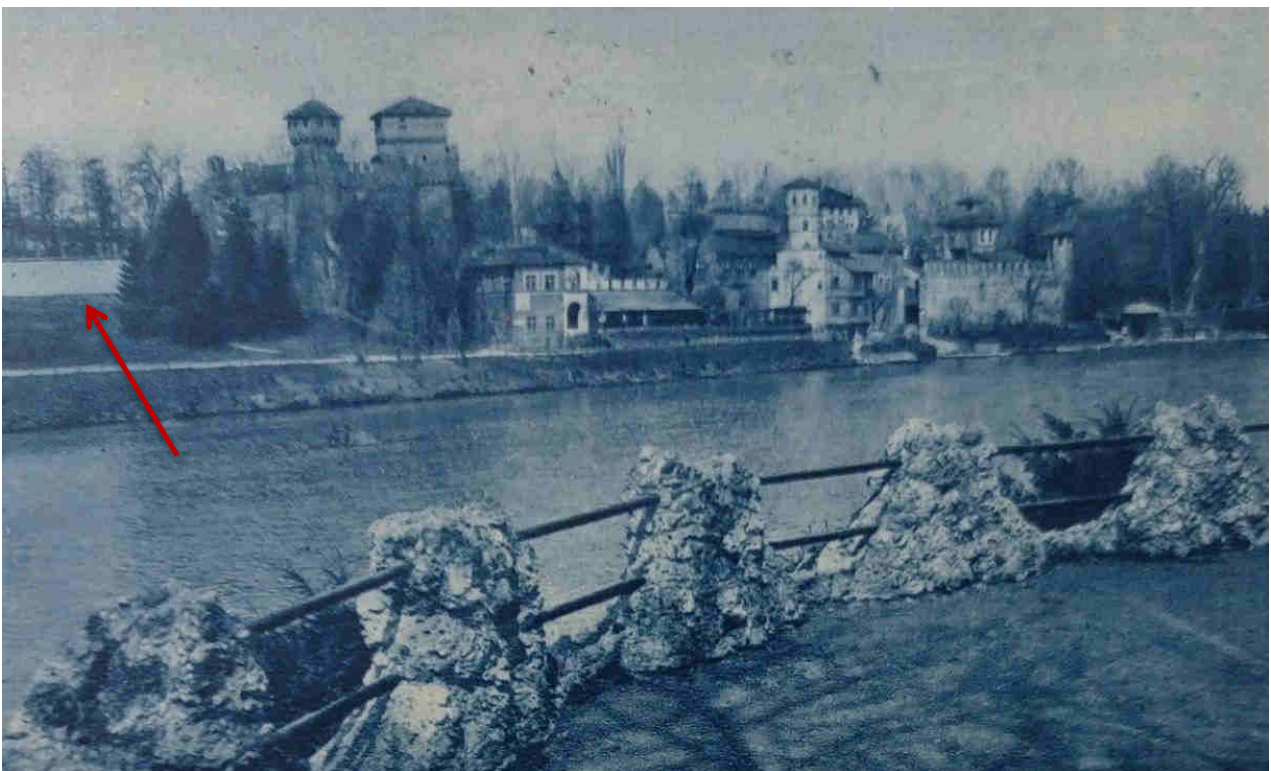
Il retro dell'edificio dell'aquarium visto dal fiume
