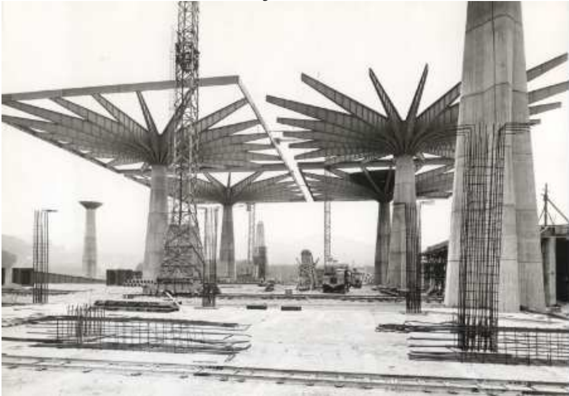
Vista area di cantiere Italia 61
