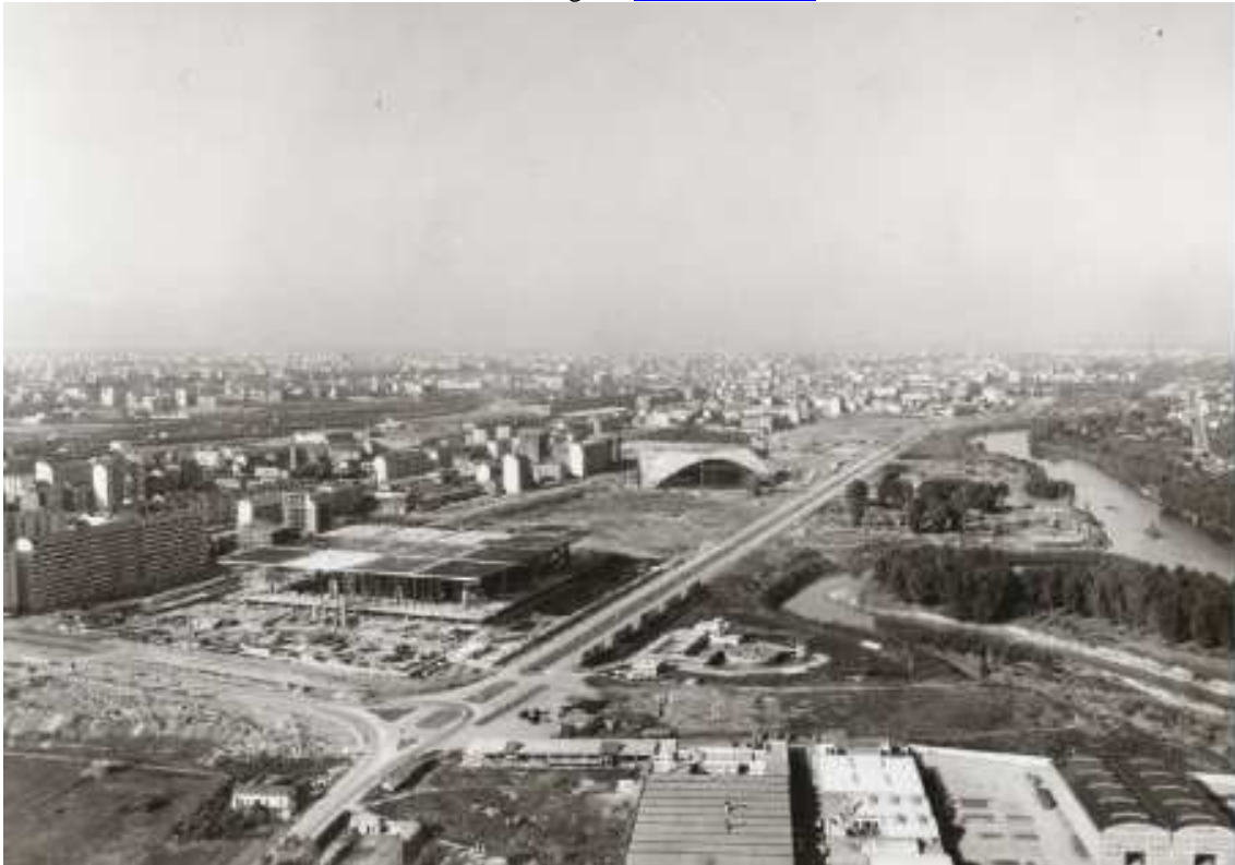
Vista area di cantiere Italia 61
