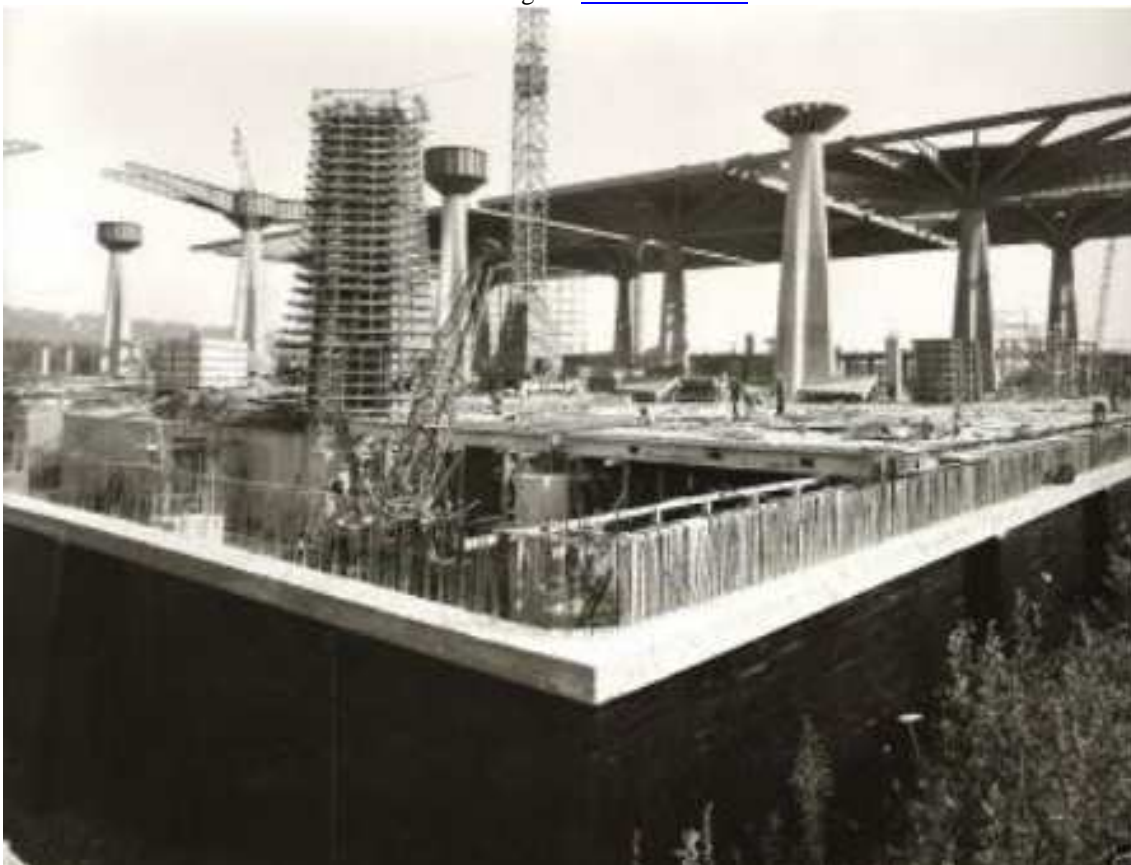
Vista area di cantiere Italia 61
