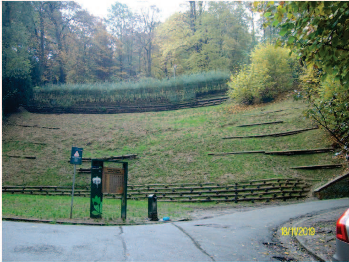
Interventi di sistemazione sull'accumulo di frana
