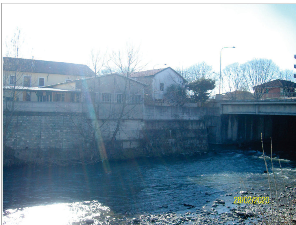
Foto 2. Il muro che funge da argine a protezione delle case in sponda sinistra. Il ponte sulla Dora é quello di Corso Potenza. La foto é scattata a monte del ponte dalla sponda destra
