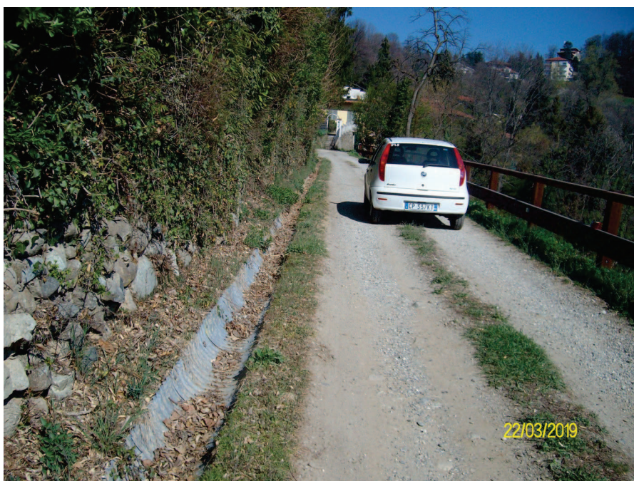
Canaletta di scolo acque meteoriche lato monte strada vicinale
