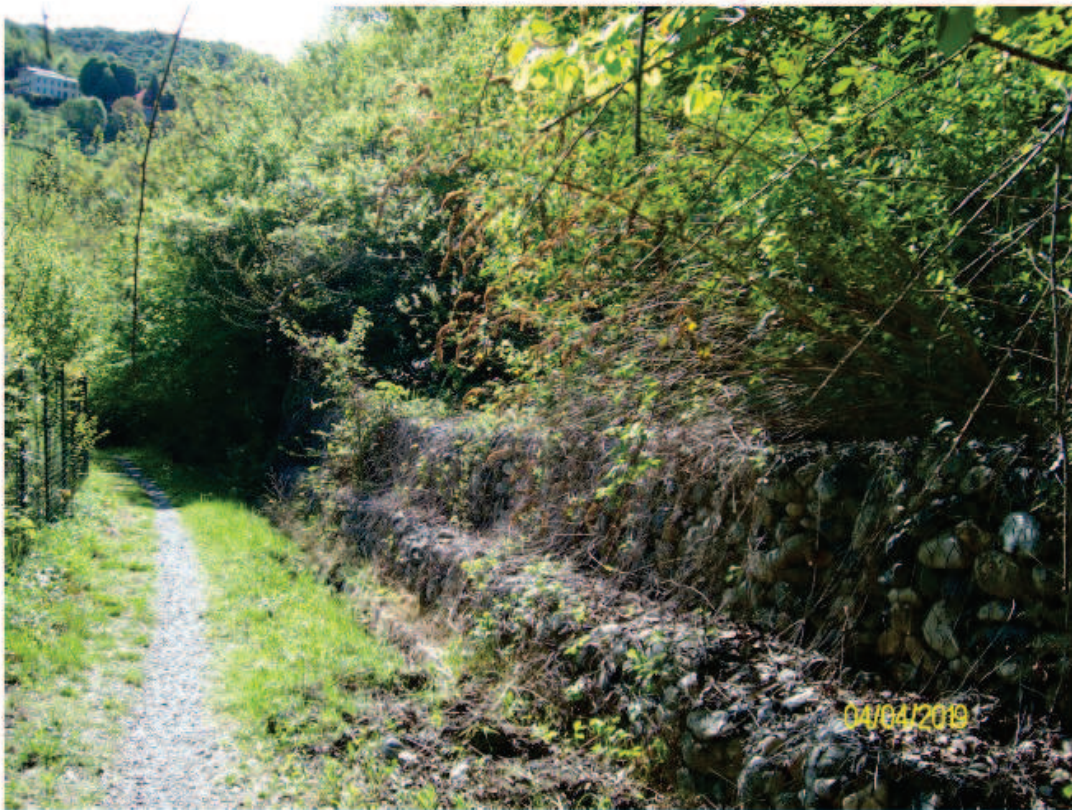
Interventi di sistemazione sul corpo di frana: gabbionate
