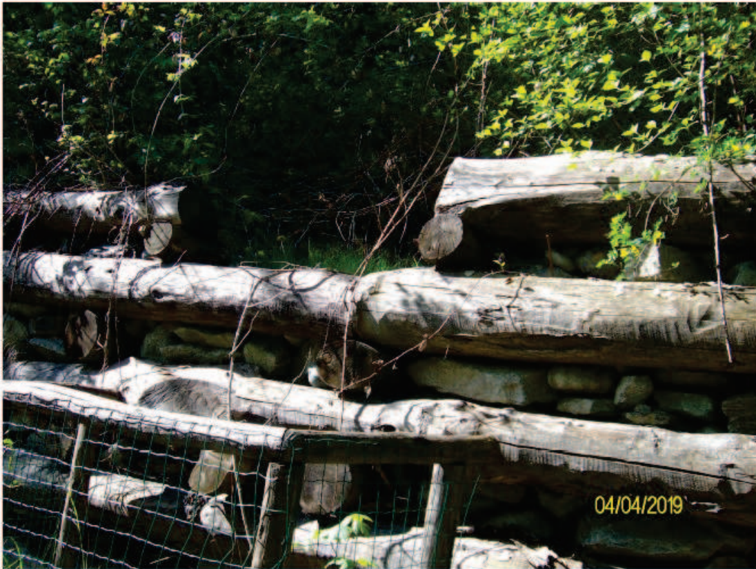
Interventi di sistemazione sul corpo di frana: palificate in legno
