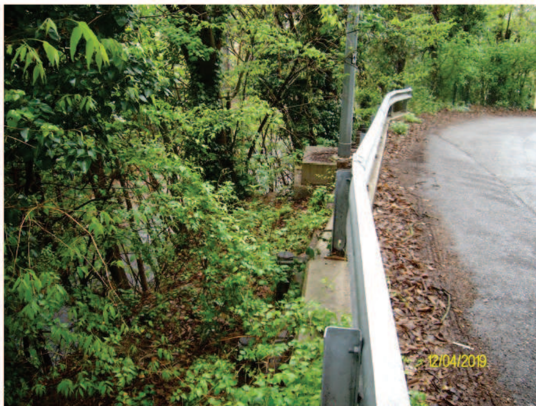
Muro in cx armato realizzato a protezione della strada comunale
