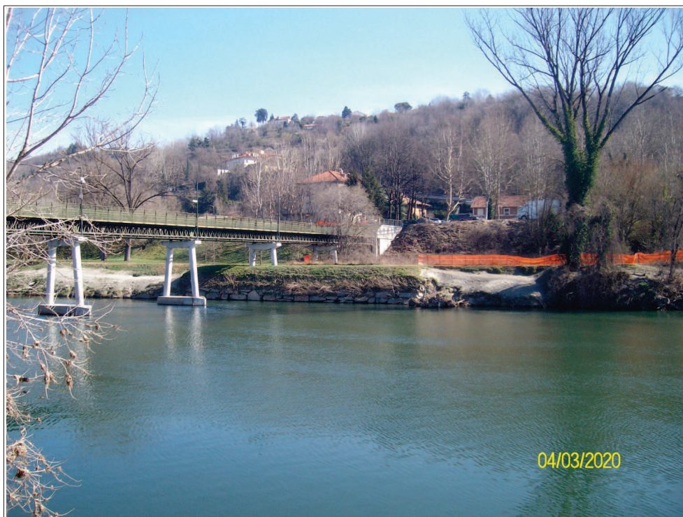
Foto 6. Subito a monte della passerella pedonale sul Po, si osserva una accentuata erosione della sponda destra
