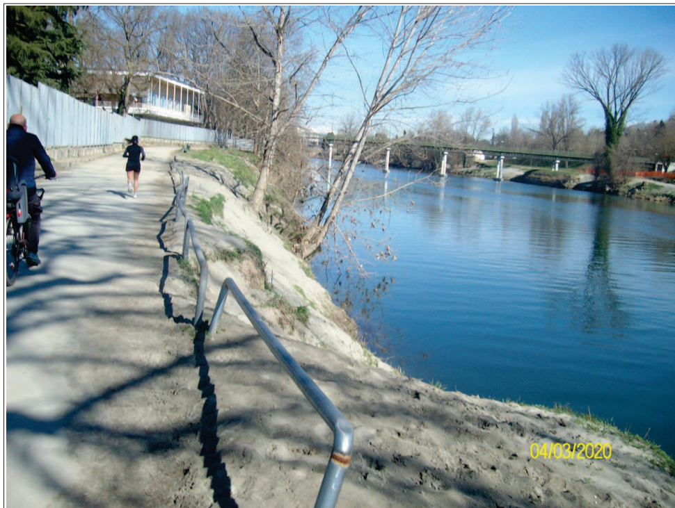
Foto 8. Sponda sinistra del Po nei dintorni dell'International Training Center. Si notano la sponda erosa e il deposito di sabbie.
