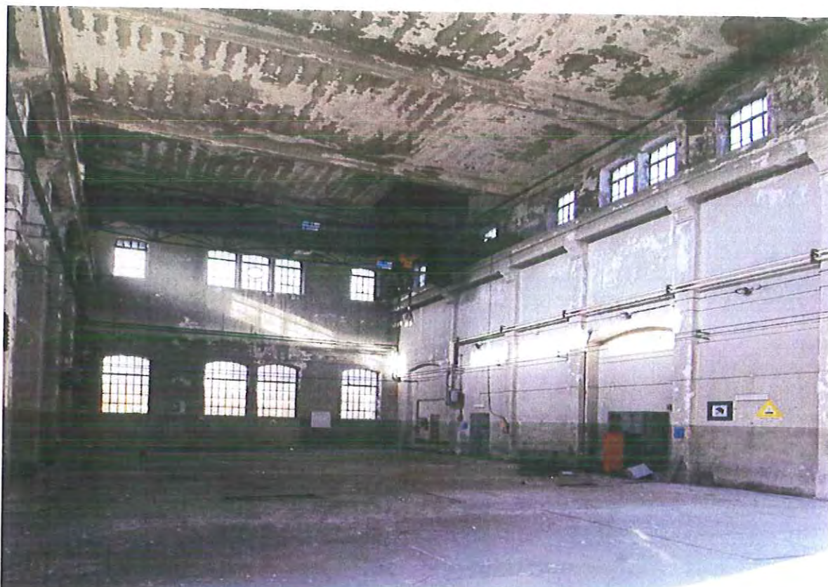
Vista interna edificio storico ex-magazzino
