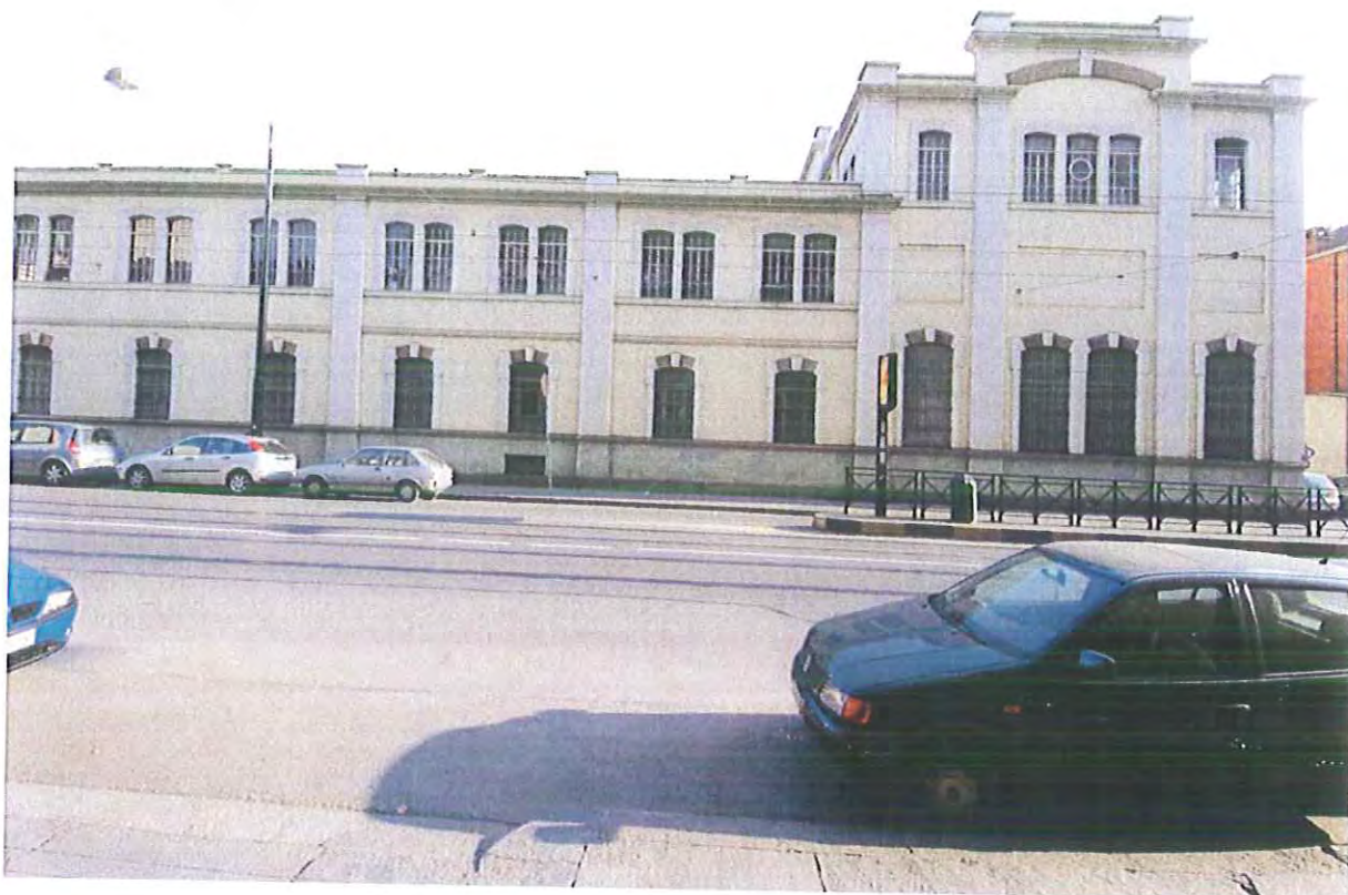
Facciata storica Ex-magazzino su via Bologna
