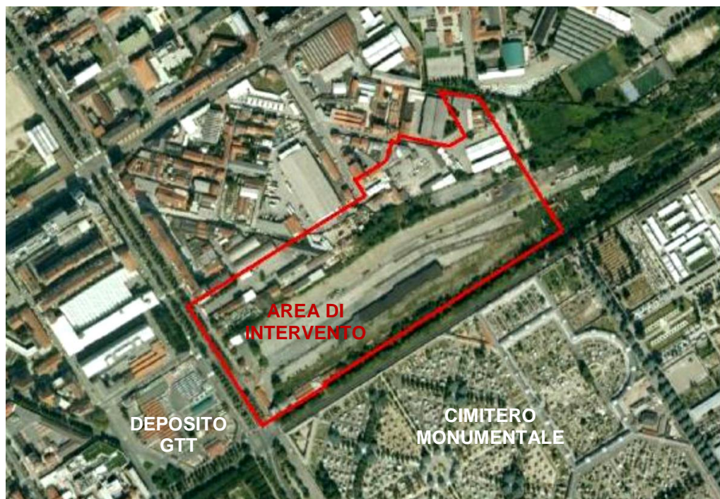
Figura 11: Fotografia aerea con in evidenza l'area di intervento.
