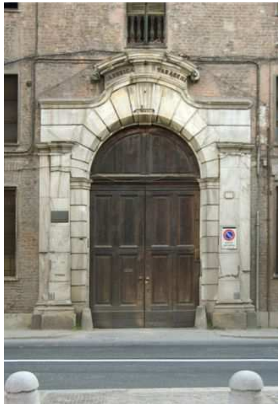
Vista ingresso ex Manifattura Tabacchi lato corso Regio Parco
