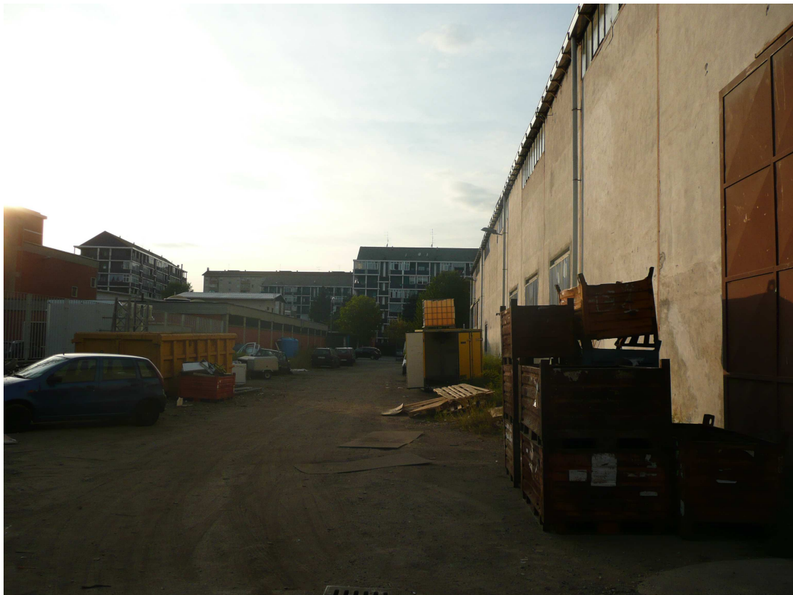
Vista interna strada oggetto di Variante lato B C– Strada del Drosso 128
