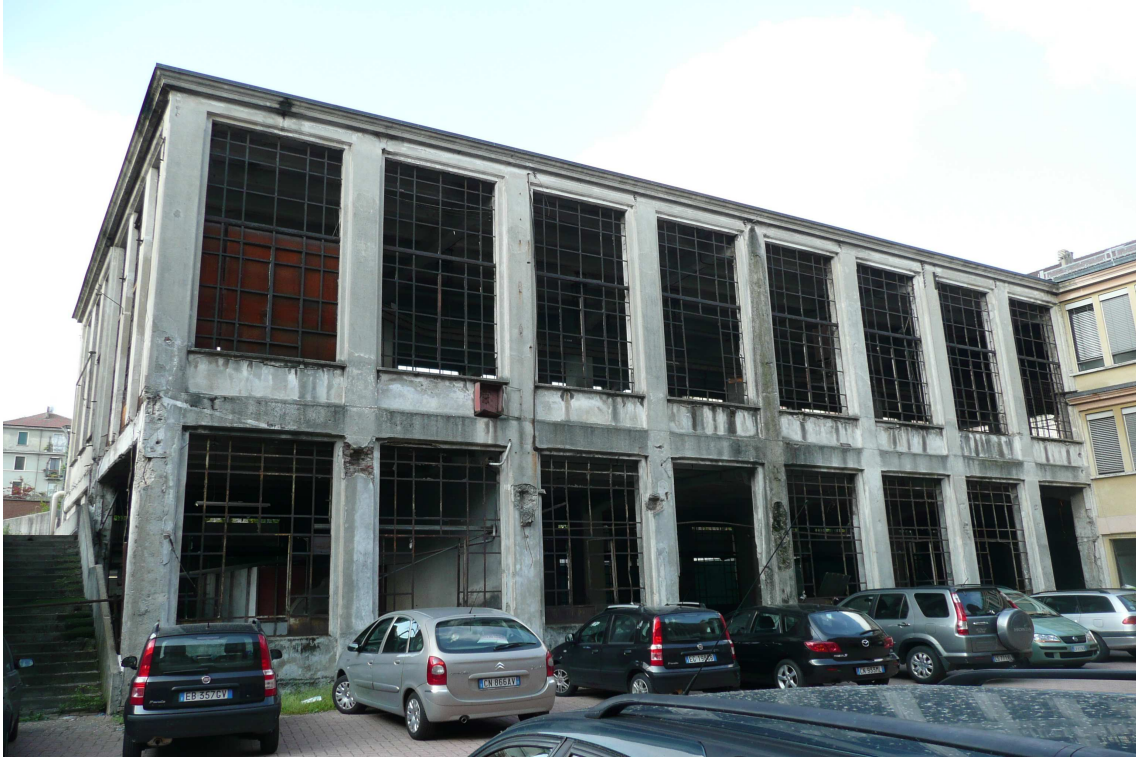
Prospetto interno cortile
