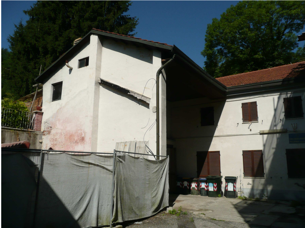
Vista da strada dei Calleri
