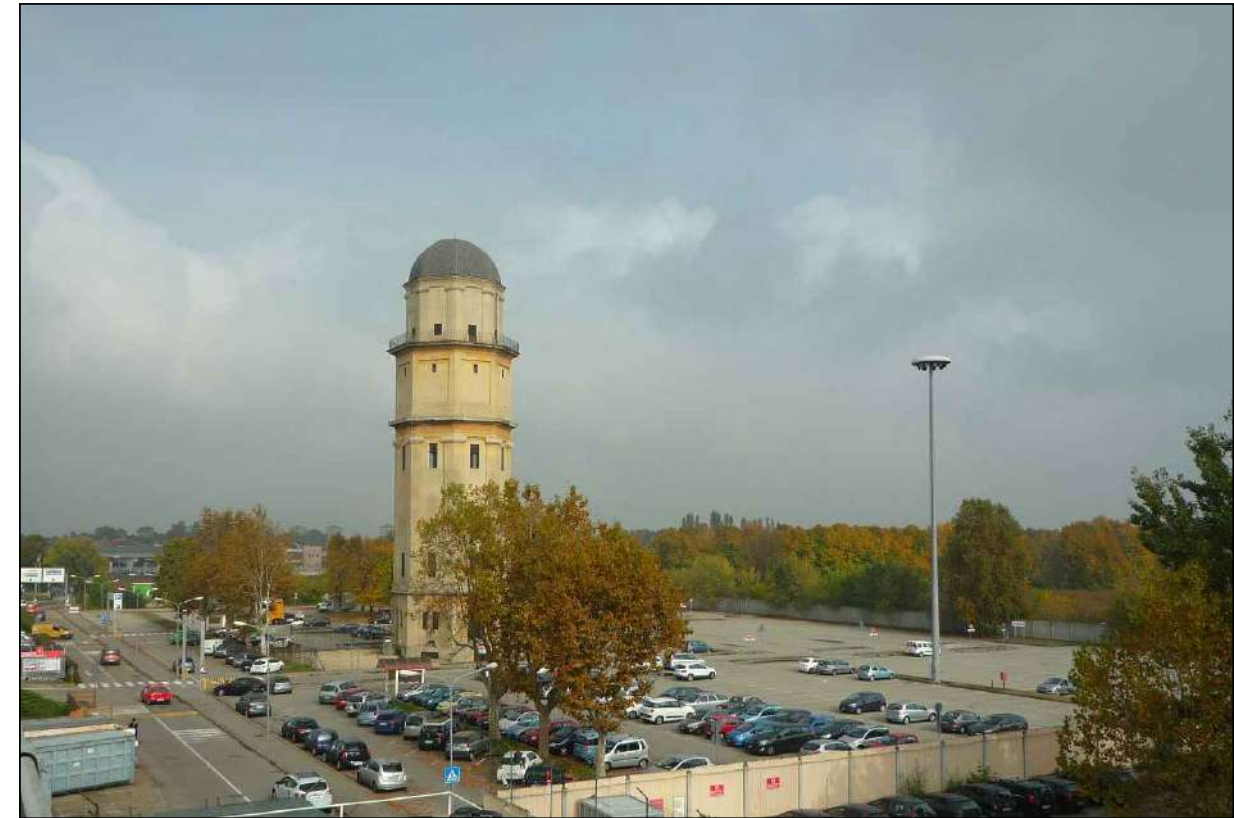
AMBITO 2.8/2 | TORRE PIEZOMETRICA
