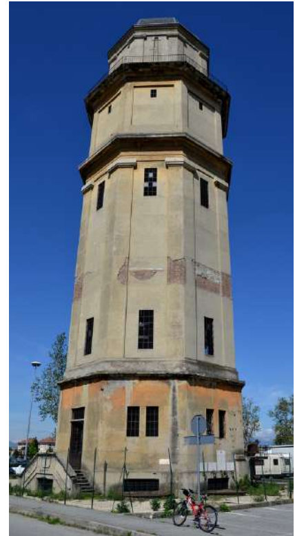
Figura 1 La Torre Piezometrica oggi
