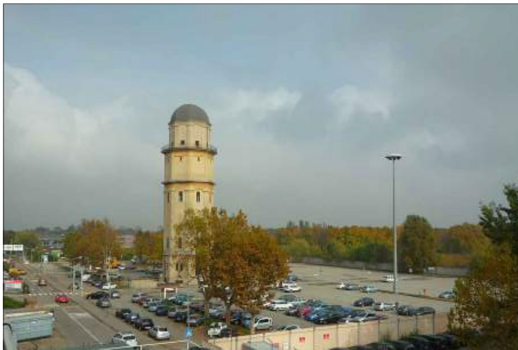
Figura 7: Ripresa fotografica torre piezometrica
