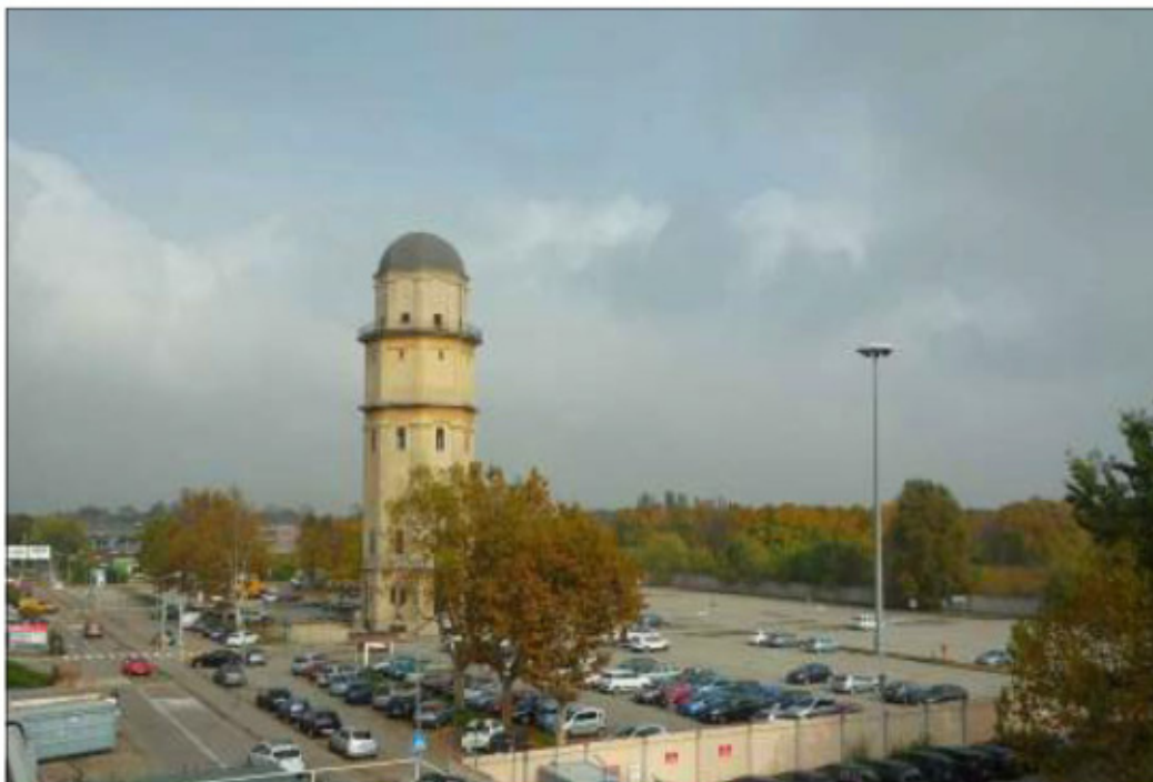
Figura 15: Ripresa fotografica torre piezometrica
