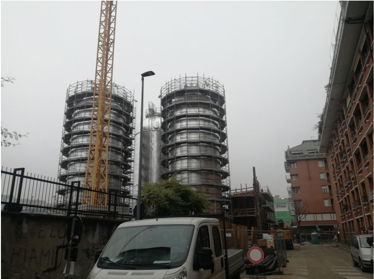
Figura 29: Serbatoi di accumulo IREN in via di realizzazione a sud dell'area oggetto di PEC. Sullo sfondo il nuovo centro di biotecnologie molecolari
