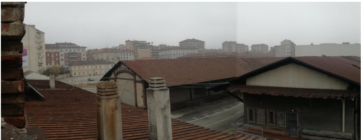
Figura 40: Vista dal sovrappasso di Corso Sommellier verso l'area oggetto di PEC e gli edifici da demolire
