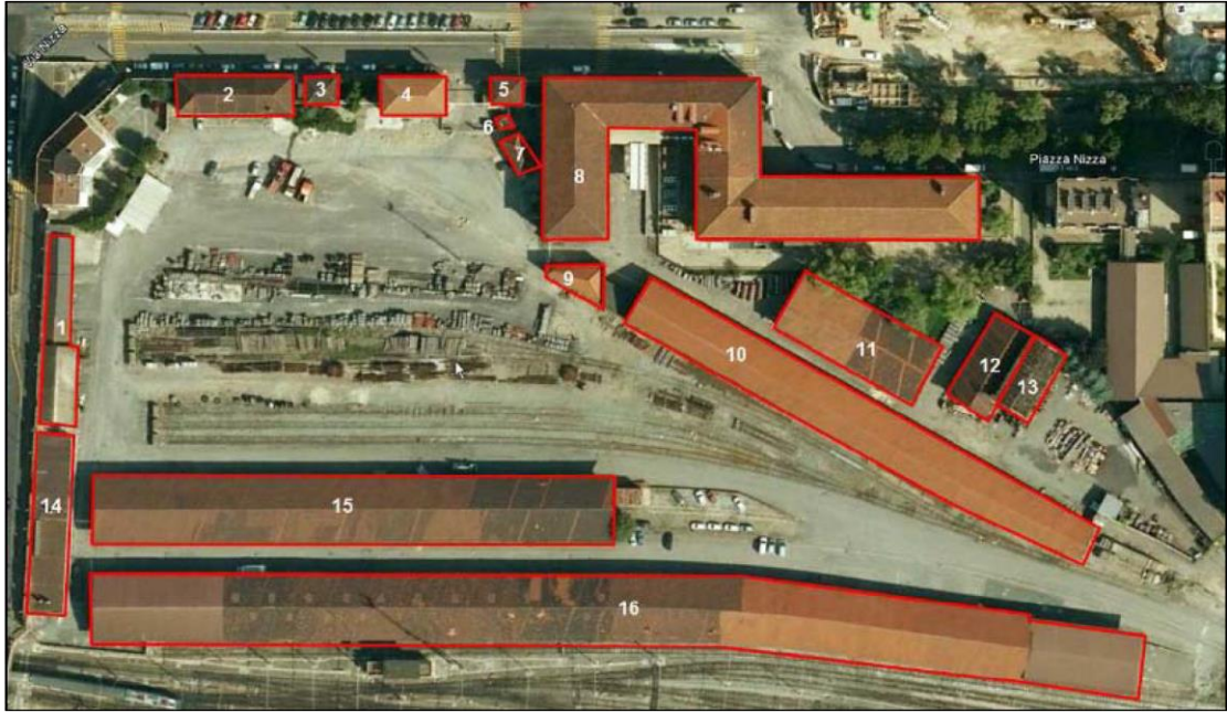
Figura 25 – Vista aerea prima delle demolizioni effettuati per la costruzione del Centro di Biotecnologie Molecolari
