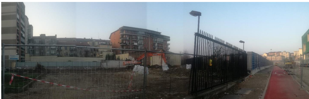
Figura 28: area in cui è previsto il centro sportivo, in cui recentemente sono stati demoliti gli edifici presenti
