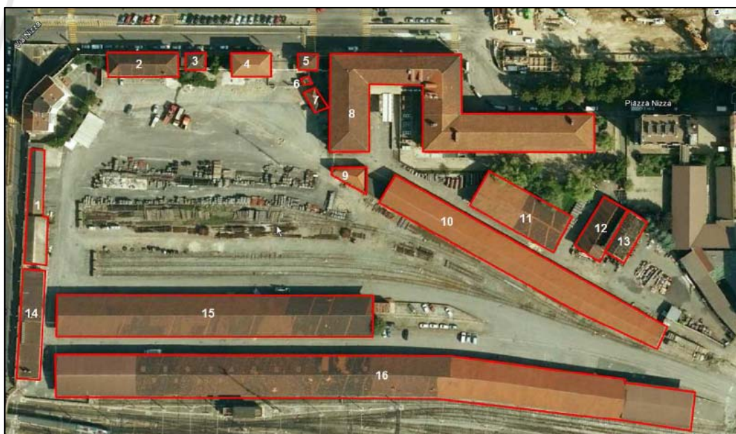
Figura c – Vista aerea del sito precedente agli interventi di demolizione effettuati per la costruzione del Centro di Biotecnologie Molecolari
