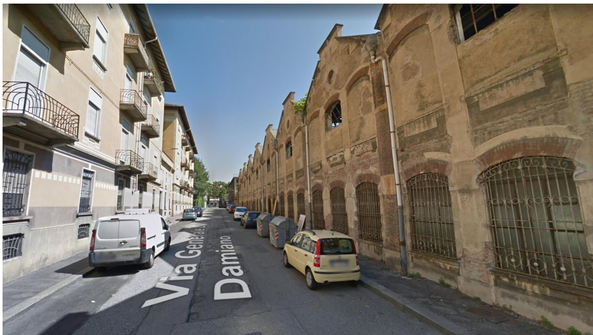
Fronte lungo Via Damiano dell'edificio industriale progettato da Pietro Fenoglio
