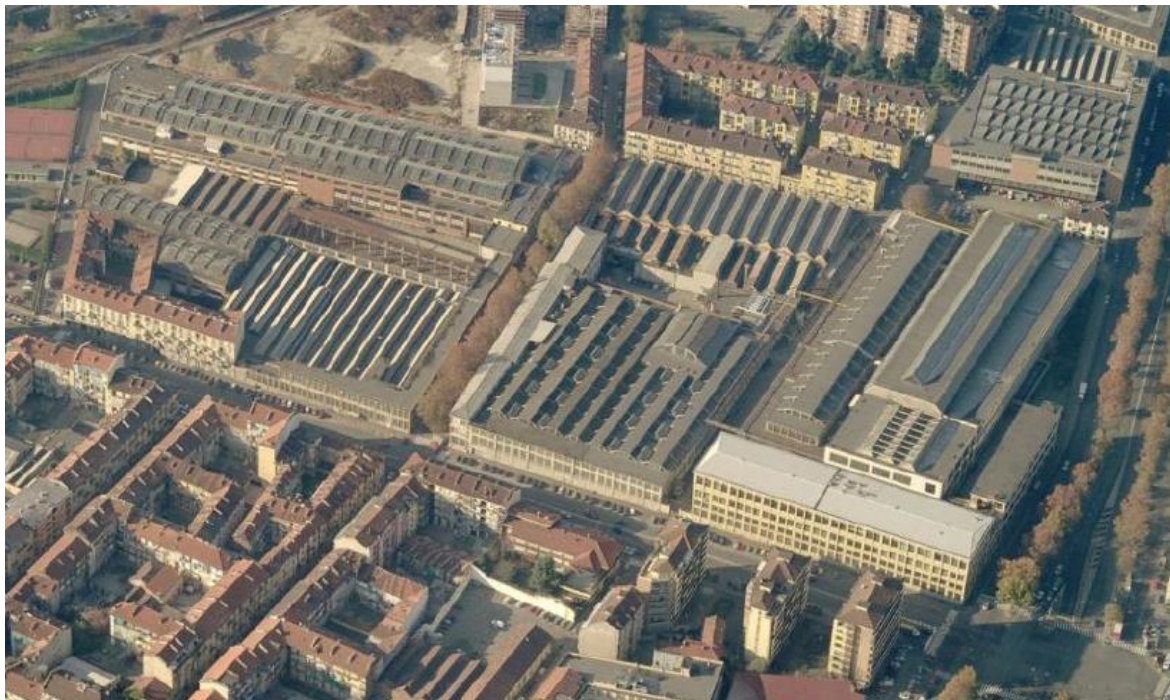
Vista dell'area di progetto nello stato precedente le demolizioni di una parte dei fabbricati
