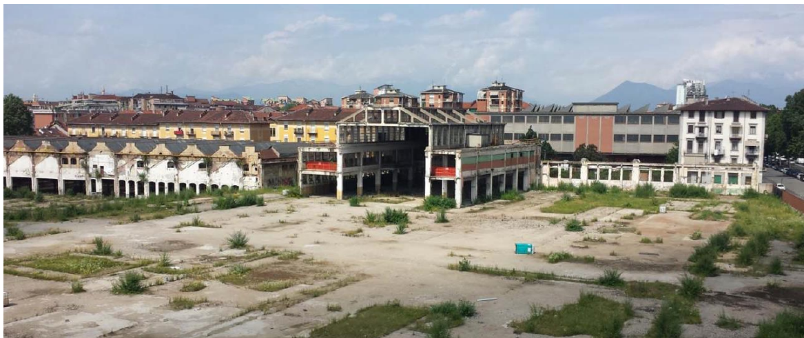
Vista attuale della parte interna dell'area del PRIN
