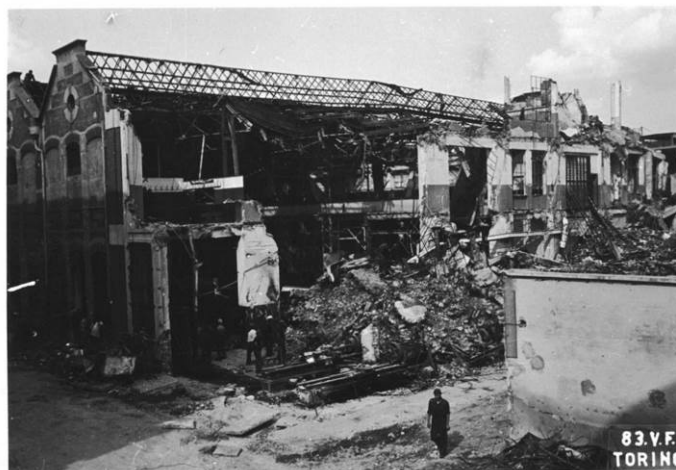
Figura 5 - Vista dello stabilimento da Via Cuneo angolo Via Damiano, in cui si notano i danni causati dai bombardamenti del 1943.
