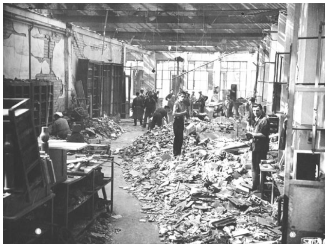
Figura 7 – Vista interna dello stabilimento di via Cuneo nella quale si evidenziano i danni dei bombardamenti durante la seconda guerra mondiale.
