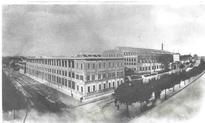
Figura 2 - Vista dello stabilimento da Corso Vigevano.
