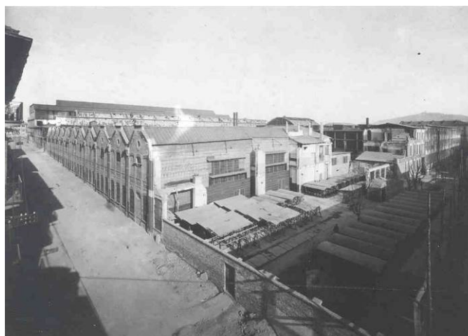
Figura 6 - Vista dello stabilimento da Via Cuneo angolo Via Damiano, in cui si notano i danni causati dai bombardamenti del 1943.
