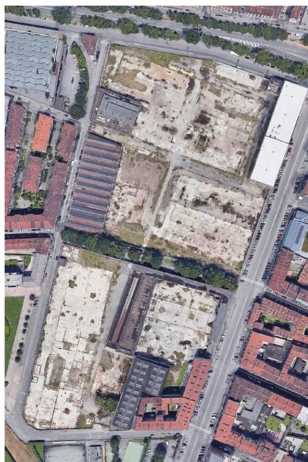
Figura 18– Fotografia aerea dell'area di intervento dopo le demolizioni
