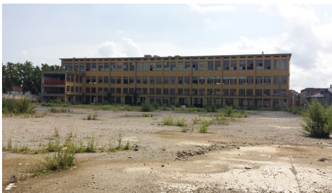
Figura 19 - Vista Lingottino dall'interno dell'area
