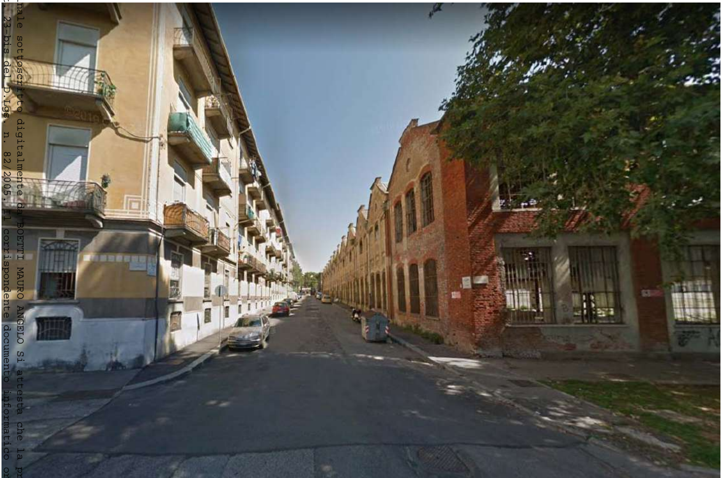
6.Via Damiano angolo Via Cuneo
