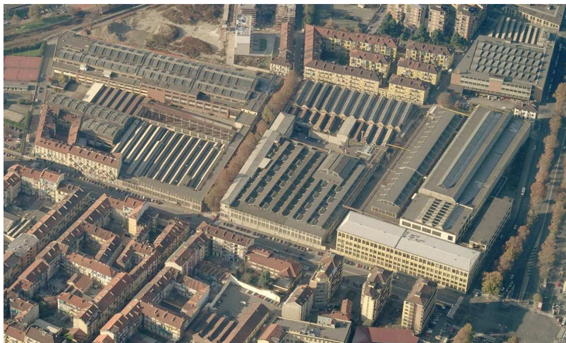
FIGURA 3 - VISTA PRIMA DELLE DEMOLIZIONI
