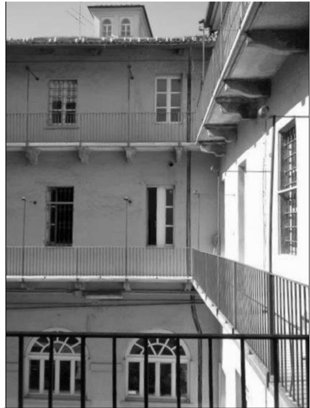
III.) 2018 | Dettaglio dei ballatoi prospicienti il cortile interno dell’ex Real Zecca.
