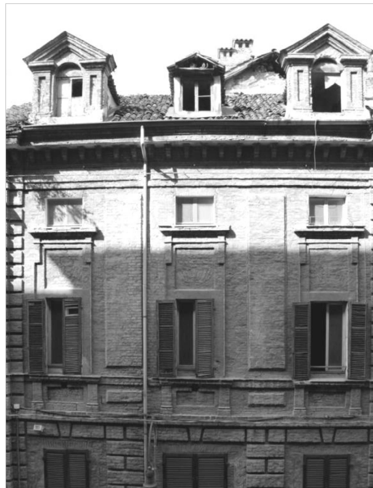
III. 2018 | Il fronte della quinta edilizia edificata prospiciente Via Verdi. Dettaglio del partito architettonico del secondo e terzo piano.
