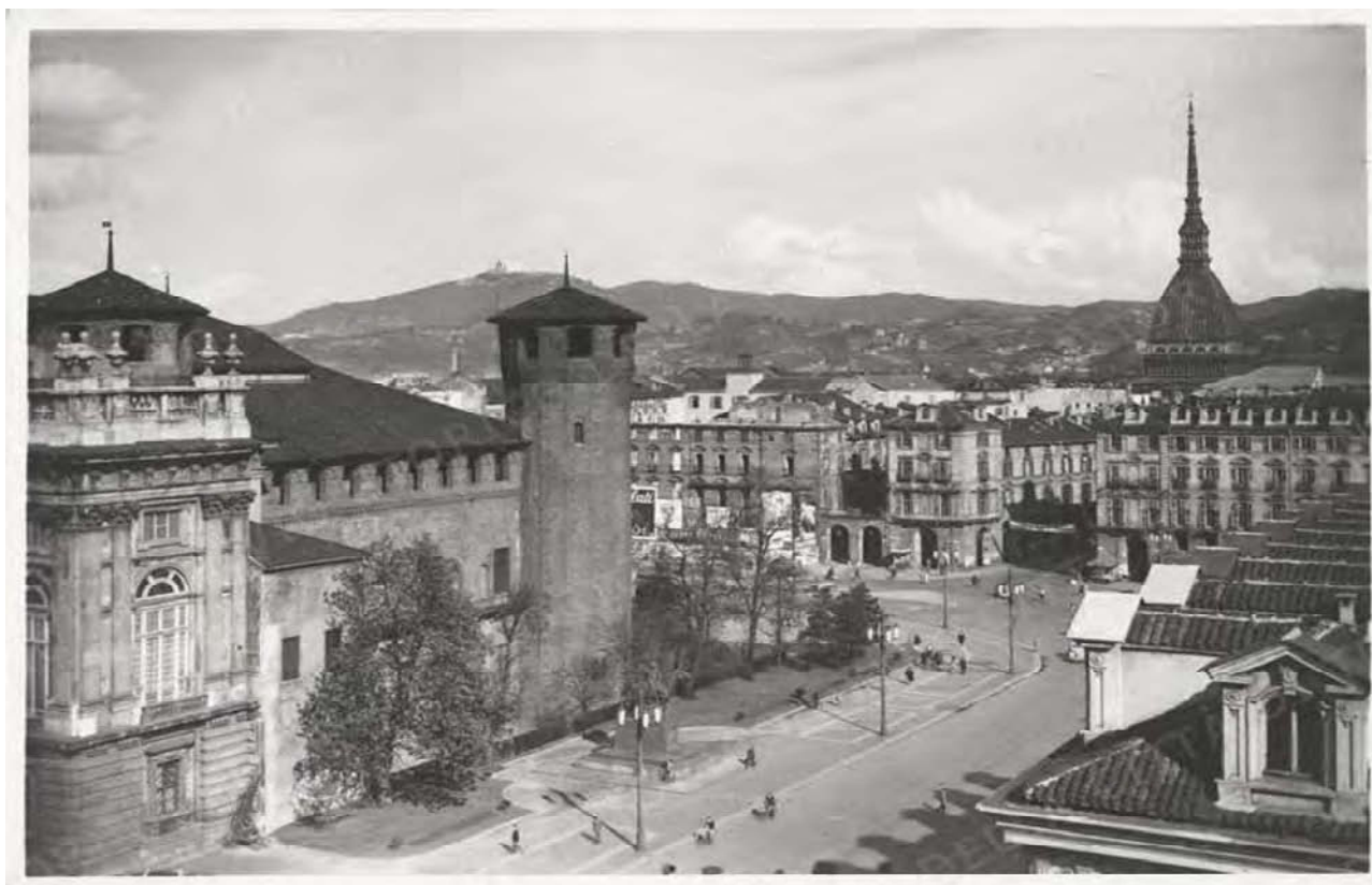
III.) Secondo Dopoguerra (1950-'55) | Veduta dell'angolo dell'Accademia Militare dopo l'incendio del Teatro Regio. Il fronte su Piazza Castello è ridotto ad una cortina muraria vuota, dalla quale s'intravede la manica residua dell'Accademia. La testata dell'Accademia e la manica prospiciente via Verdi, già Contrà della Zecca, con coperture dotate di abbaini si presentano ancora parzialmente integre.
