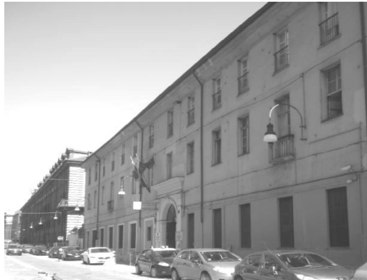
III.) 2018 | Il fronte su via Verdi dell’ex Real Zecca, ora sede Commissariato di Pubblica Sicurezza e Carabinieri.
