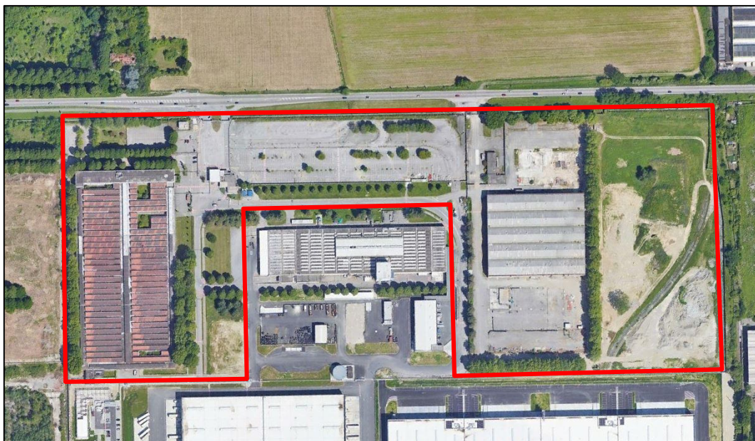
Figura a – Vista aerea del sito di intervento
