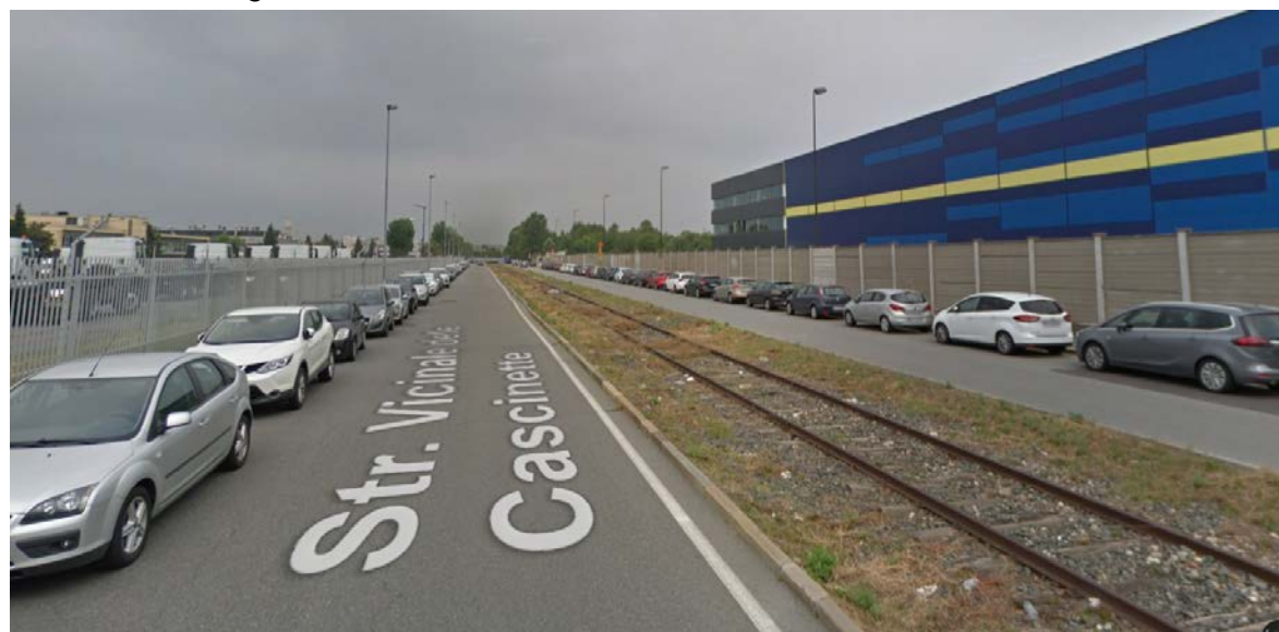
Figura 77 - Strada Vicinale delle Cascinette allo stato attuale
