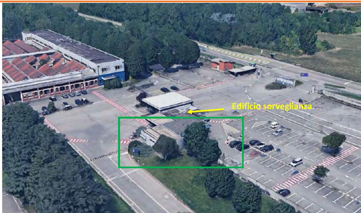
Figura 36: Individui arborei nei pressi dell'edificio di sorveglianza (accesso allo stabilimento Michelin)
