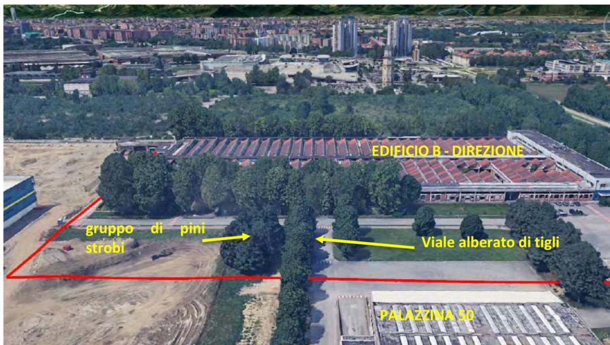
Figura 38: Inquadramento area retrostante la palazzina 50
